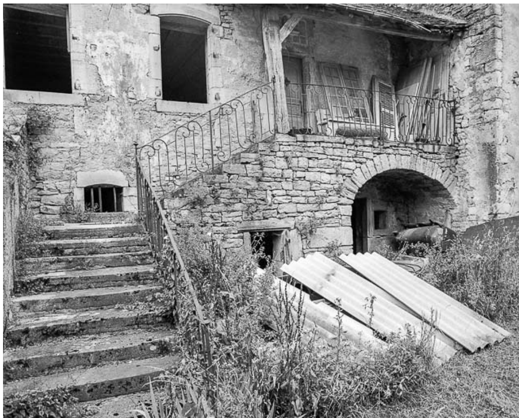
Détail de l'escalier.
