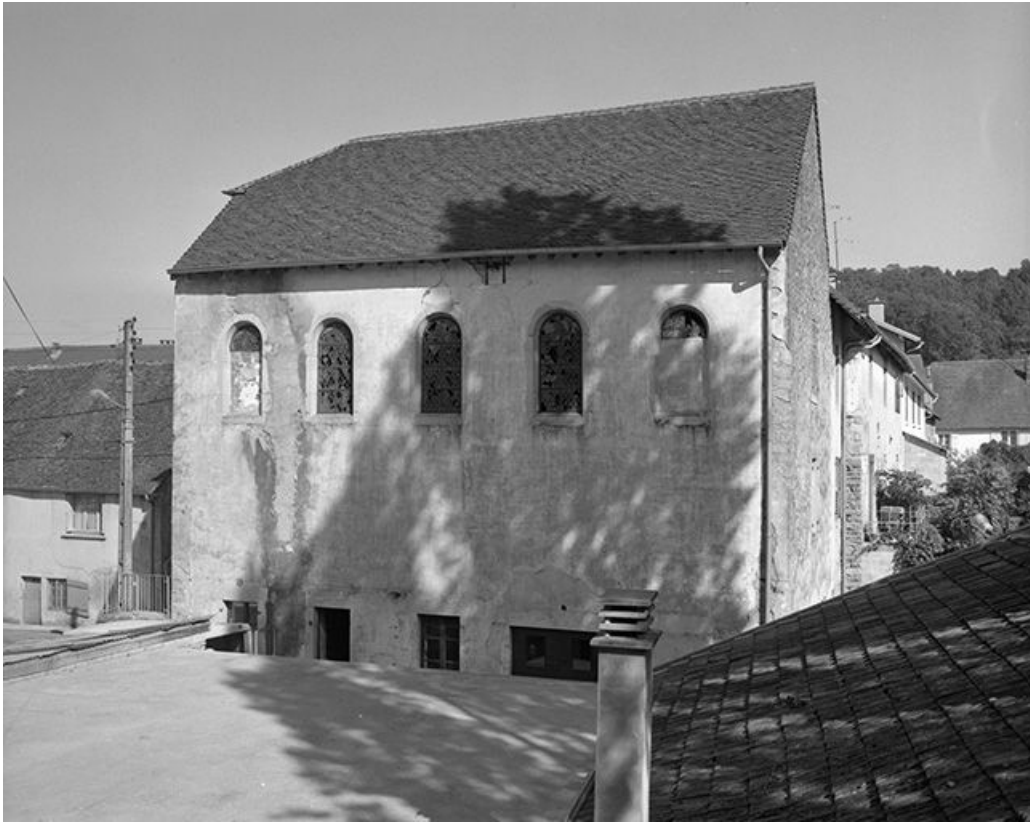
Chapelle : façade latérale droite.
