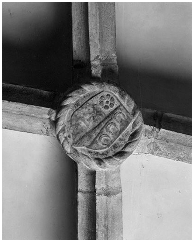
Chapelle gauche : clef de voûte.
