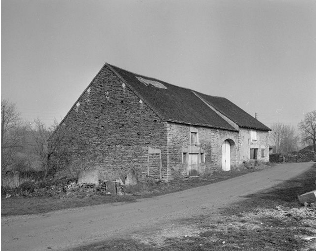
Façade antérieure et pignon gauche.
