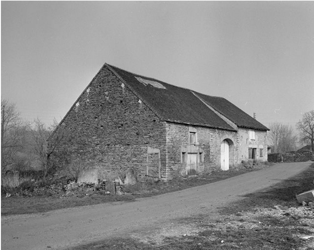
Façade antérieure et pignon gauche.
