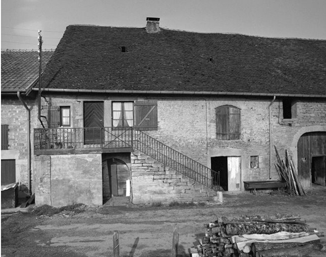
Façade antérieure : l'habitation.
