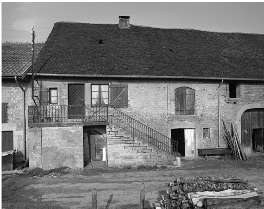
Façade antérieure : l'habitation.
