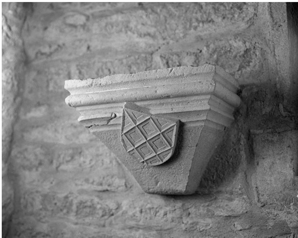
Intérieur : chapelle, mur est, console gauche.
