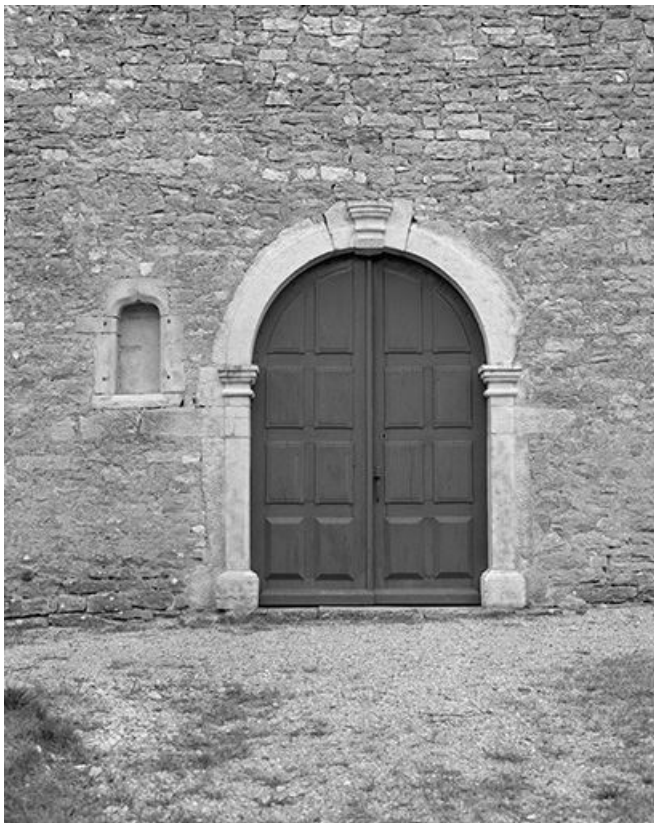
Portail de la façade antérieure.
