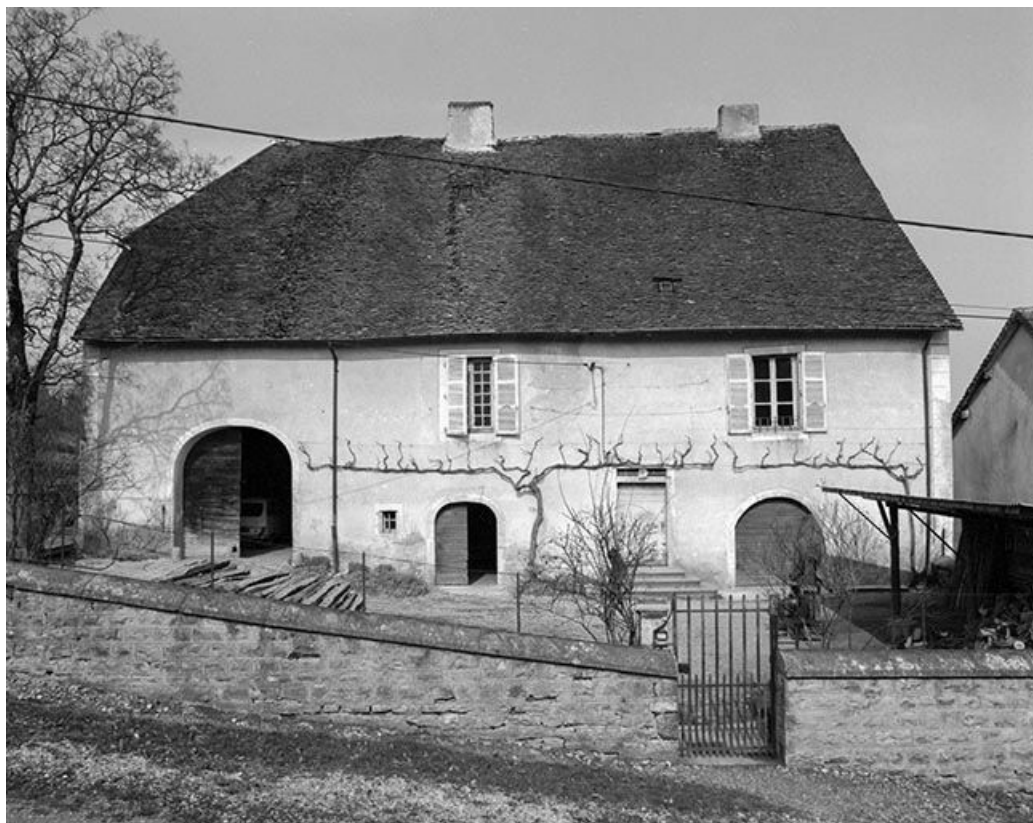
Façade antérieure, vue de face.
