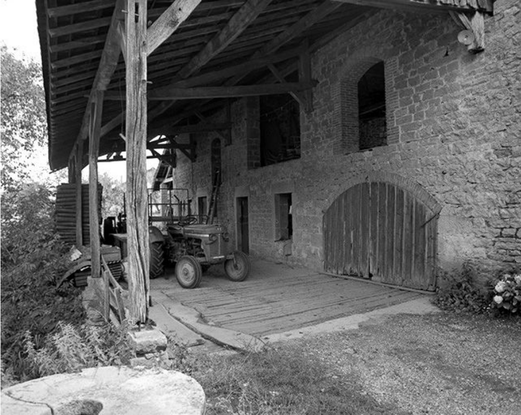
Façade antérieure, partie gauche.
