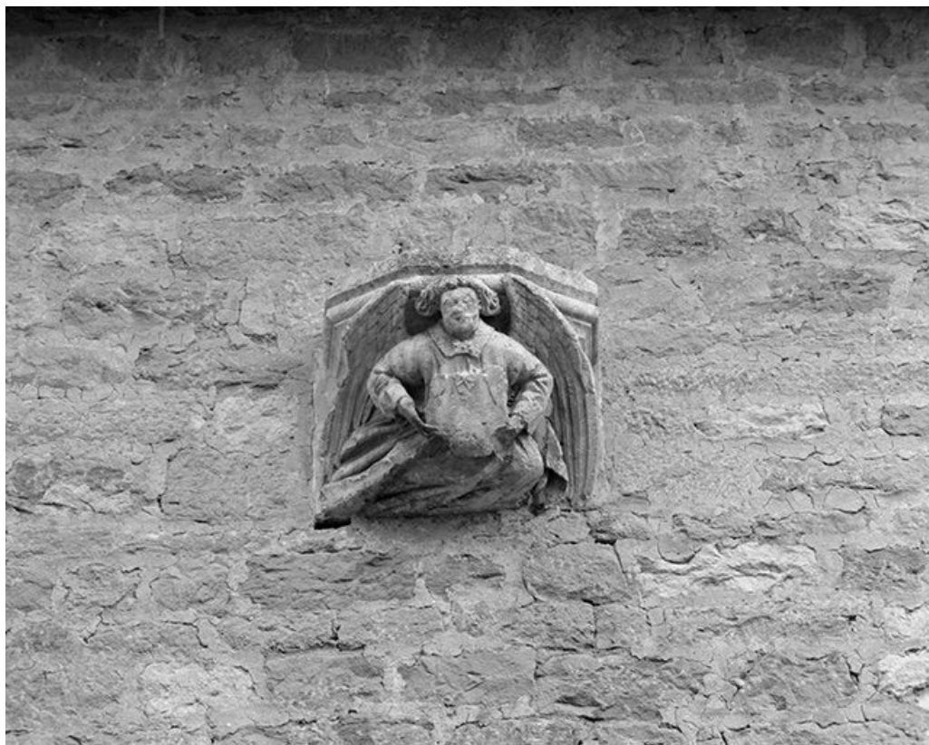
Façade antérieure : console gauche.
