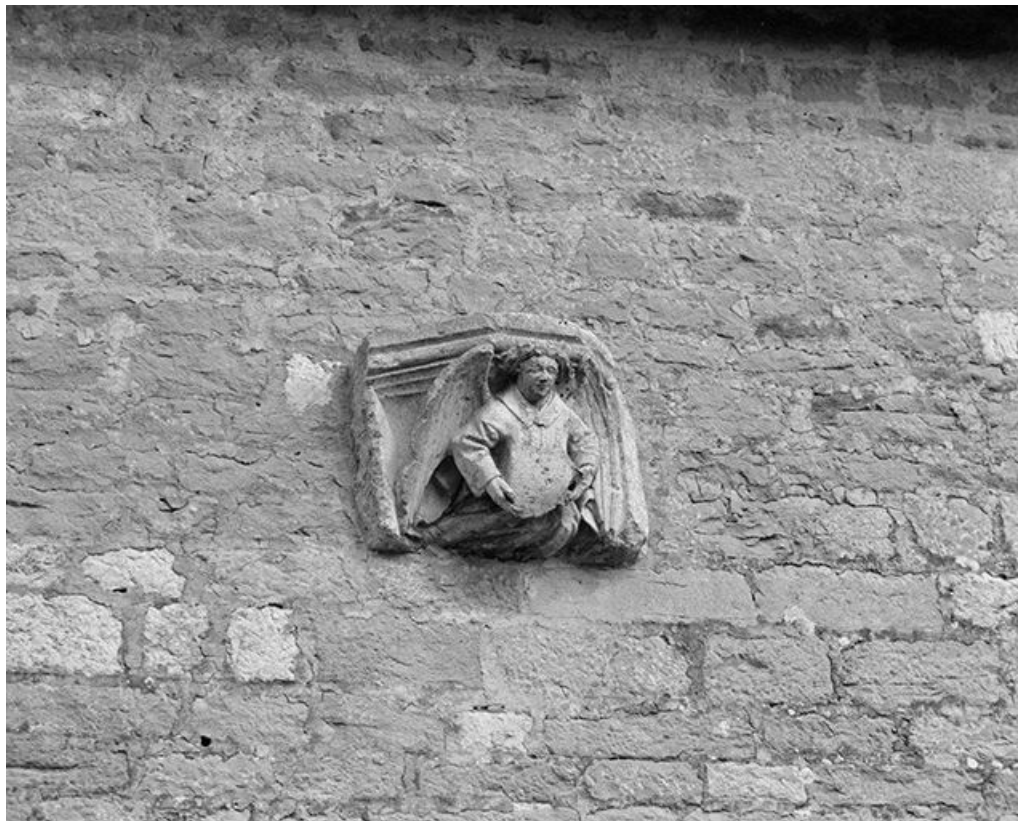
Façade antérieure : console droite.
