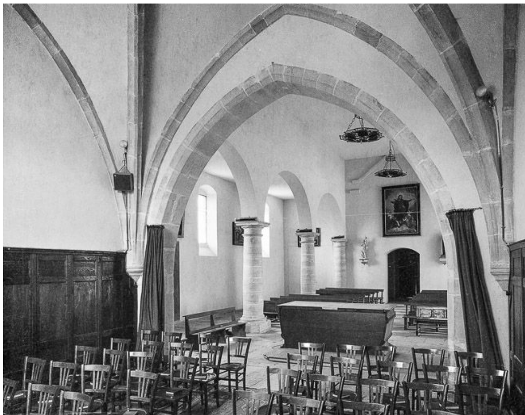
Intérieur : élévation droite de la nef.
