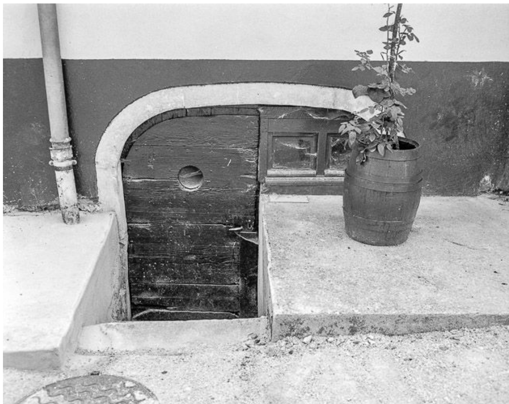
Maison : entrée de la cave.
