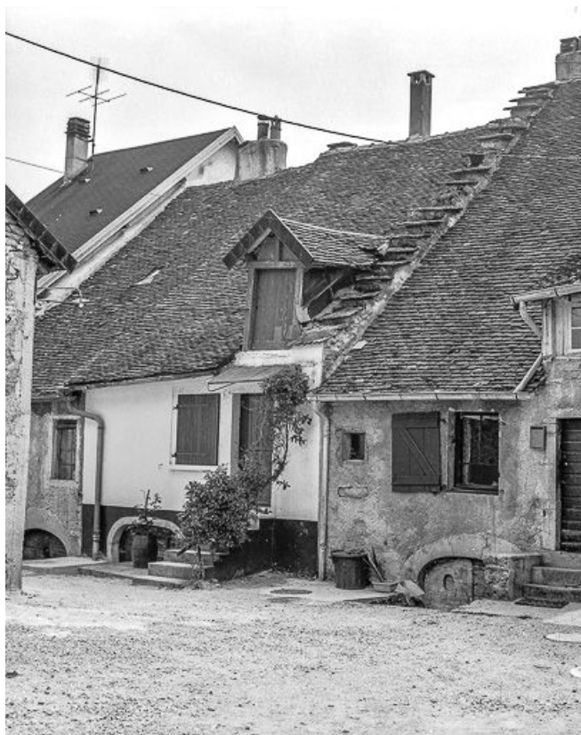
Maison : façade antérieure.
