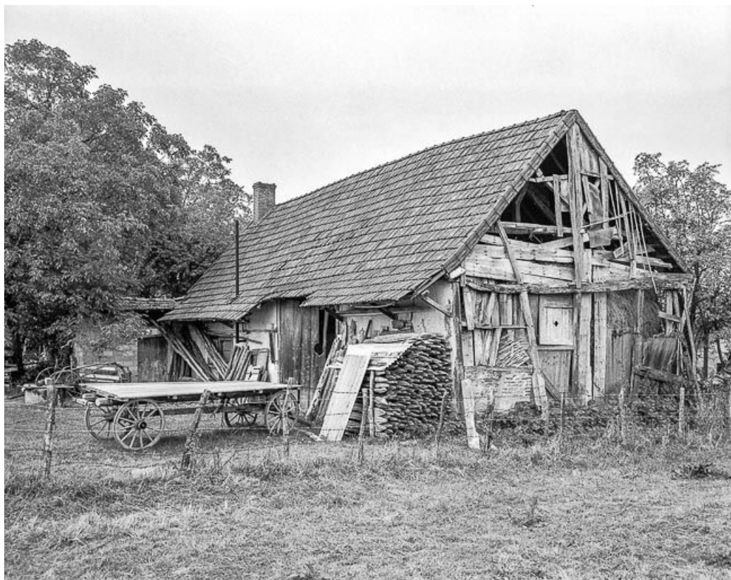
Façade antérieure et face droite.
