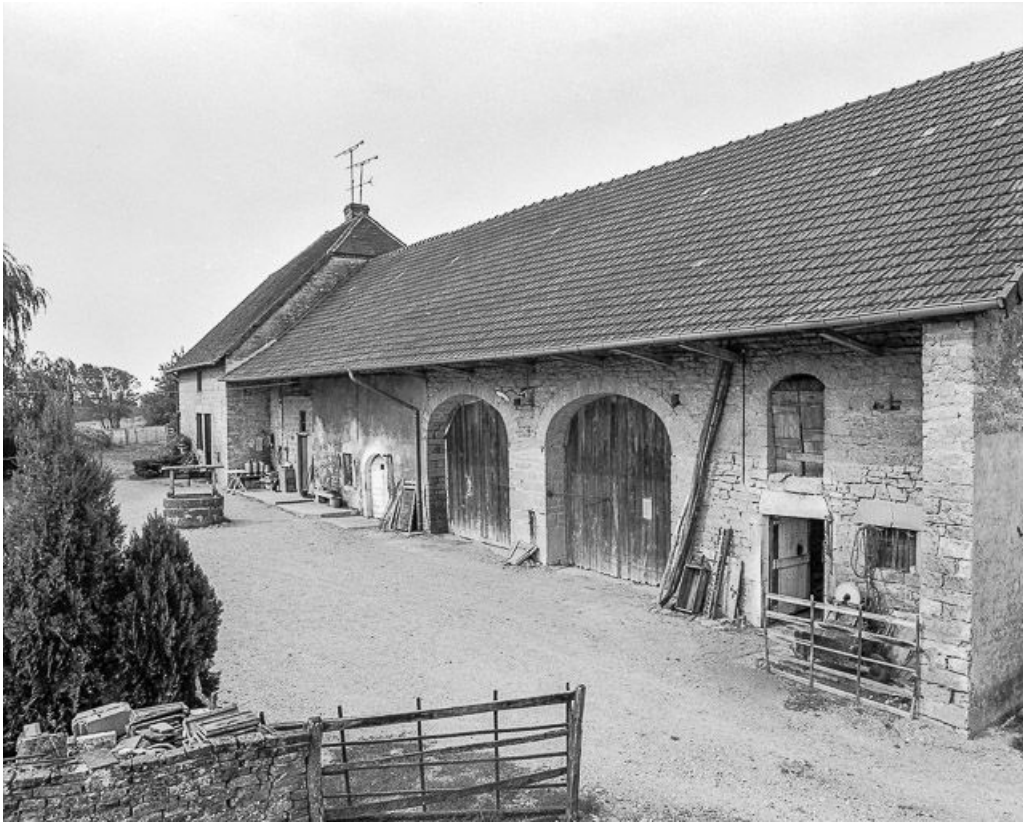
Le bâtiment à droite de la cour.
