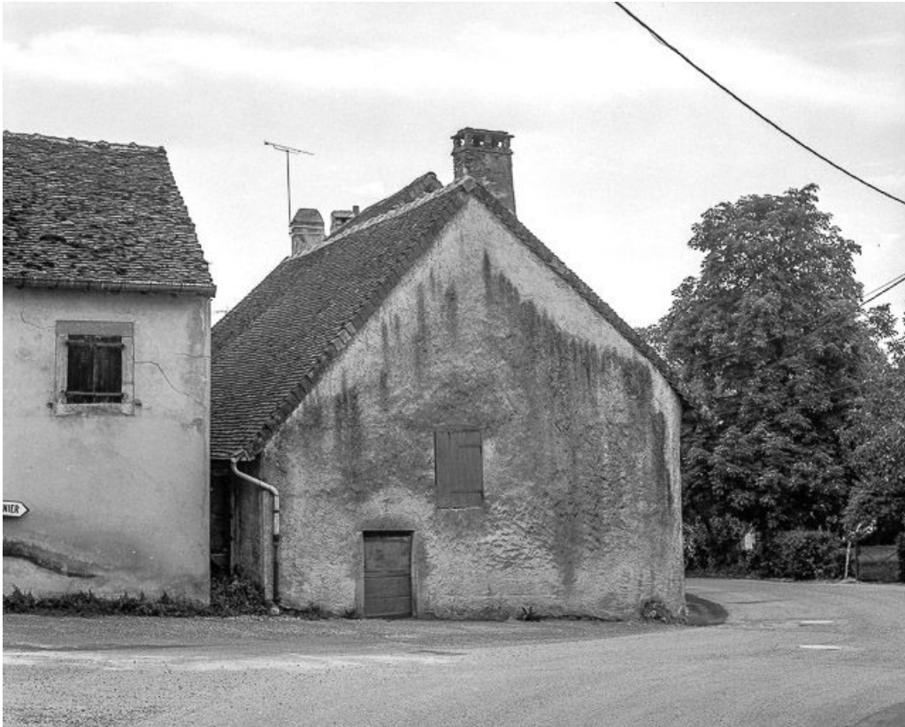
Façade latérale gauche.
