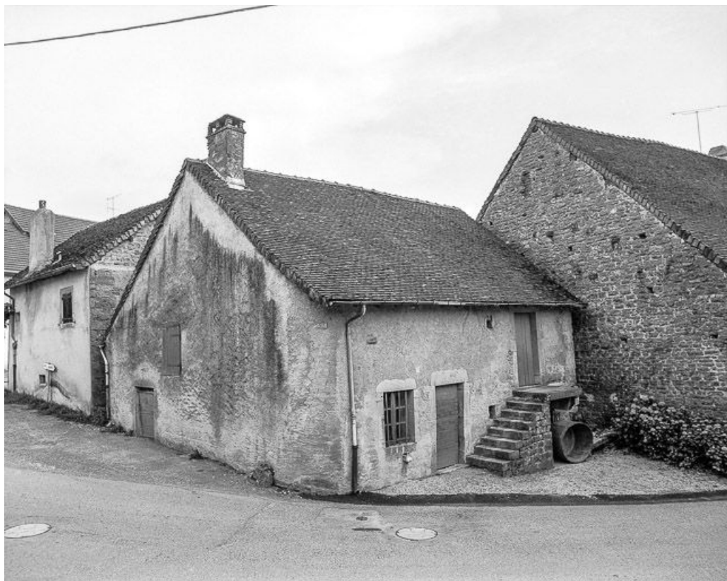
Façades antérieure et latérale gauche.
