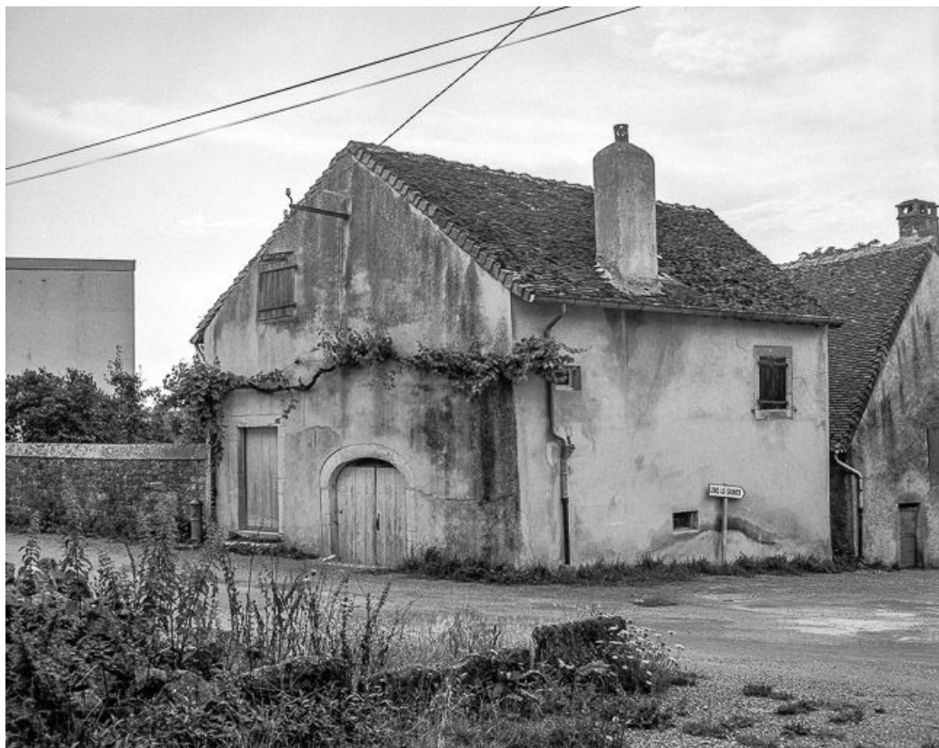
Façades antérieure et latérale droite.
