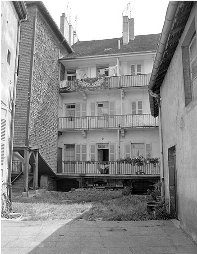
Façade postérieure montrant l'escalier à gauche.
