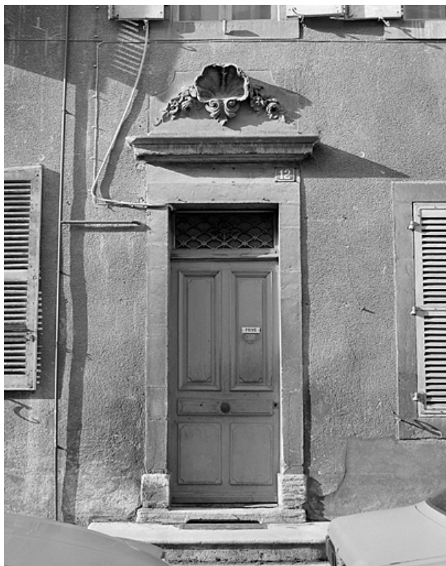
Façade antérieure, porte d'entrée.
