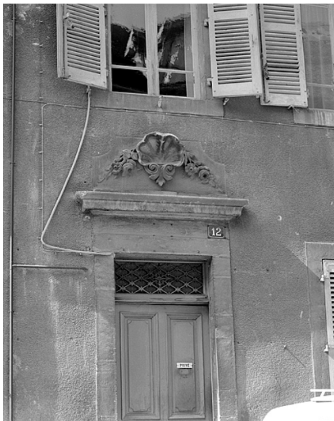
Façade antérieure, porte d'entrée, détail.
