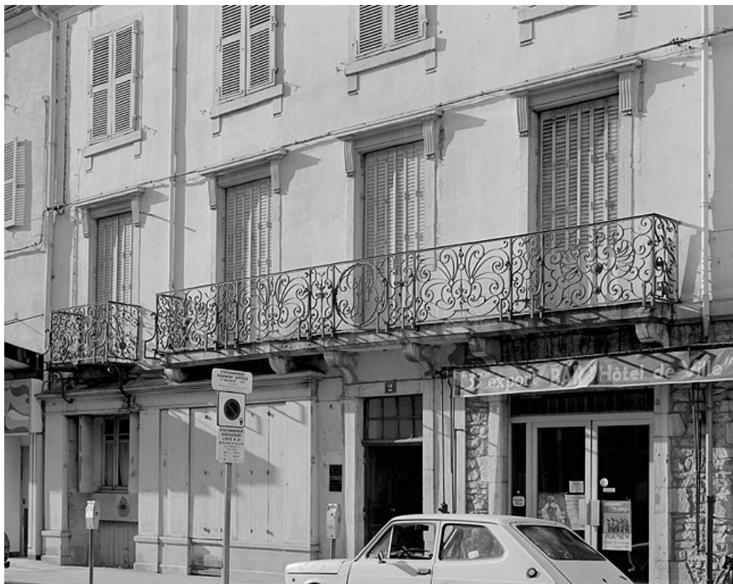
Façade antérieure, vue partielle.
