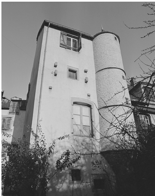
Façade sur jardin du second corps de bâtiment avec sa tourelle.
