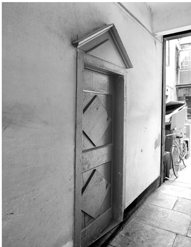
Porte du logement donnant dans le couloir de communication entre la cour et la rue.
