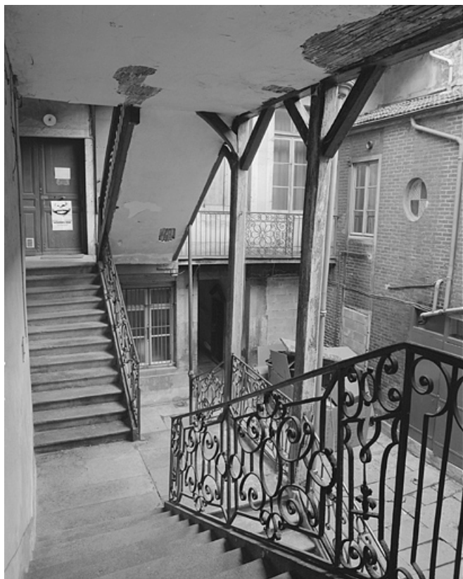
Escalier dans la cour, vu depuis le premier palier.
