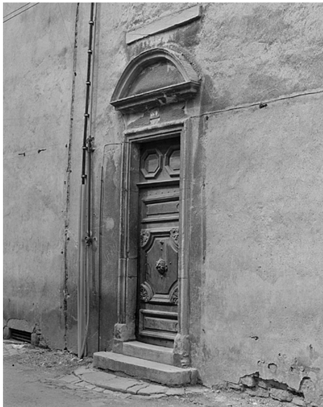
Façade latérale, porte d'entrée.
