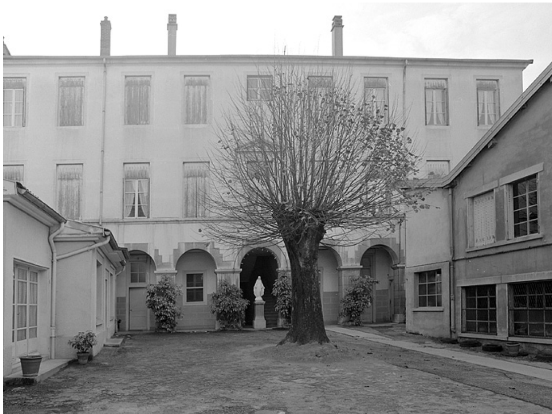
Bâtiment annexe, façade sur la cour.
