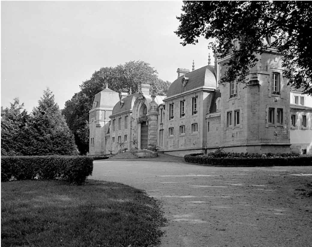
Façade antérieure vue de trois-quarts.
