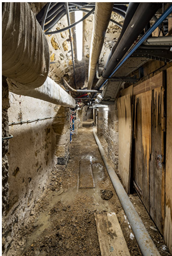
Galerie nord du sous-sol, sous le vestibule.
