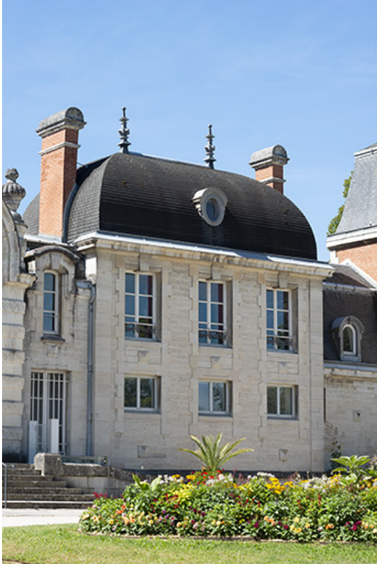
Façade principale, pavillon occidental. 39, Lons-le-Saunier avenue Camille Prost
