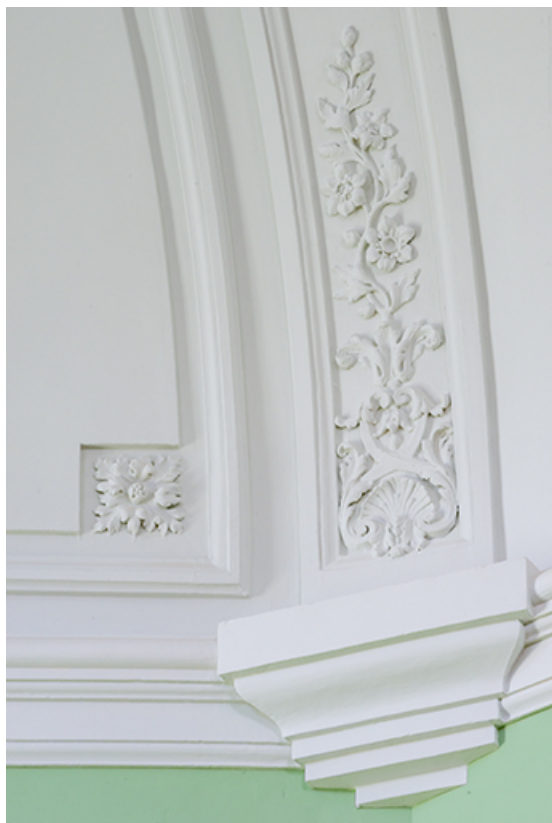
Salle de repos (ancienne salle d'attente), nervure du couverture. 39, Lons-le-Saunier avenue Camille Prost
