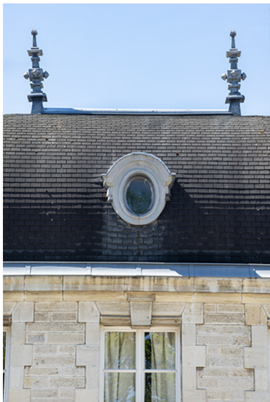
Façade principale, pavillon occidental, détail.
