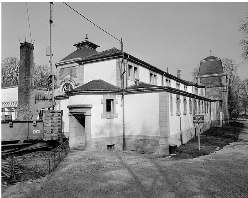
Vue de trois-quarts de la façade latérale gauche.
