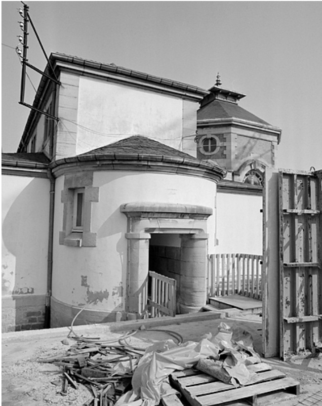
Corps d'entrée sur la façade postérieure.
