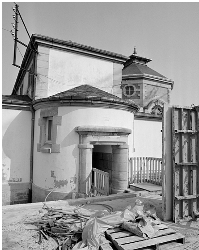
Corps d'entrée sur la façade postérieure.
