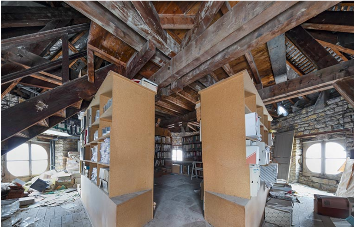
Comble au-dessus de l'ancienne salle d'attente.
