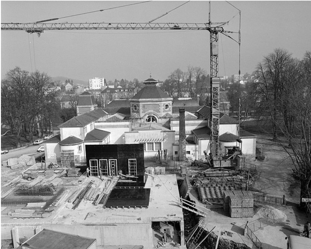
Vue générale des façades postérieures. 39, Lons-le-Saunier avenue Camille Prost
