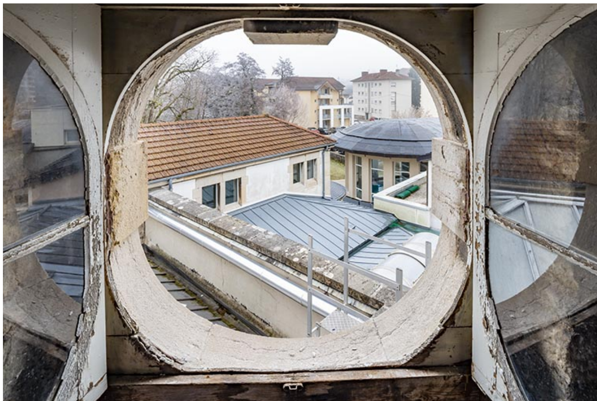
Comble au-dessus de l'ancienne salle d'attente, vue en direction de l'extension de 2007. 39, Lons-le-Saunier avenue Camille Prost
