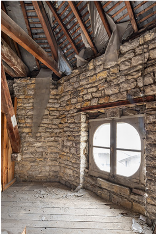
Comble au-dessus de l'ancienne salle d'attente. 39, Lons-le-Saunier avenue Camille Prost
