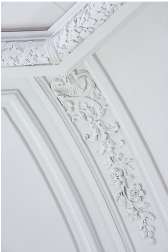
Salle de repos (ancienne salle d'attente), nervure du couvrement. 39, Lons-le-Saunier avenue Camille Prost
