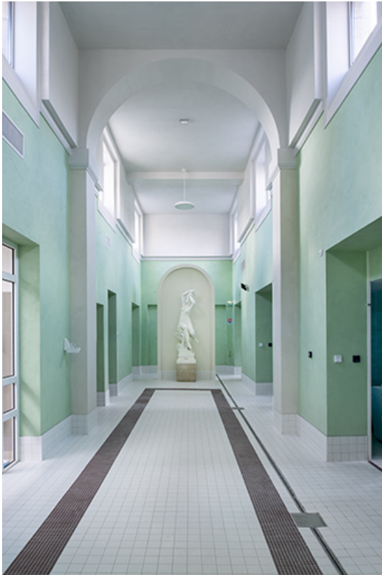
Galerie des Hommes, vue en direction du sud. 39, Lons-le-Saunier avenue Camille Prost
