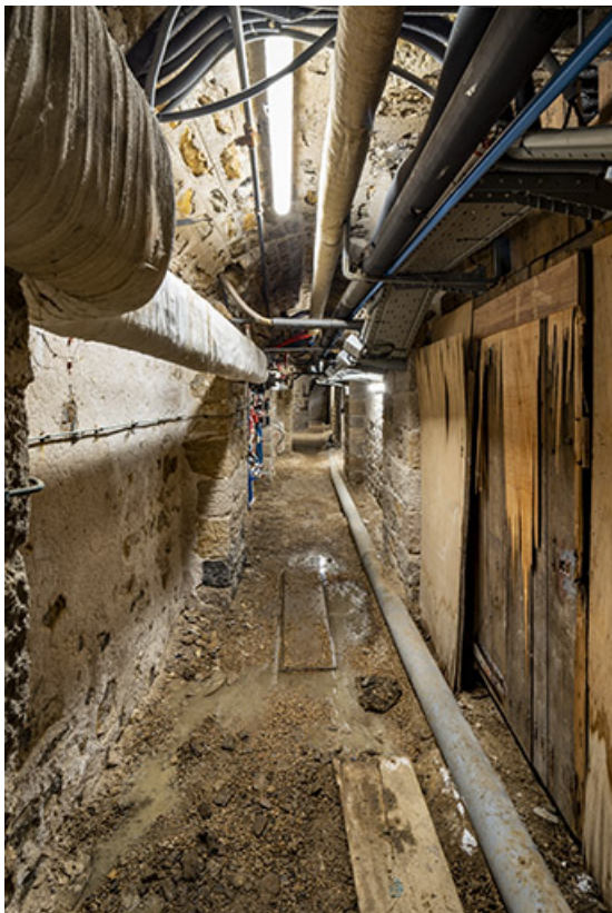
Galerie nord du sous-sol, sous le vestibule.
