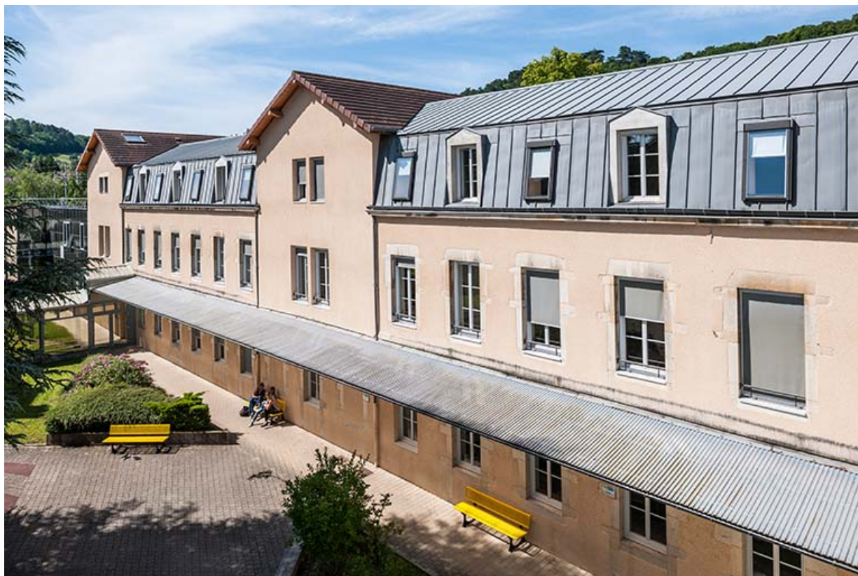
Façade Ouest sur cour de l'externat
