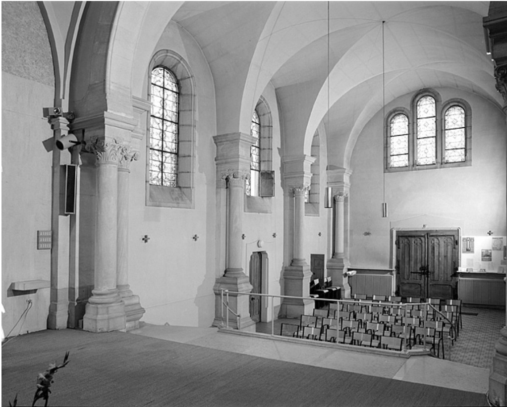
Eglise : élévation intérieure et voûtement de la nef. 39, Lons-le-Saunier, 230 rue du Docteur Jean Michel
