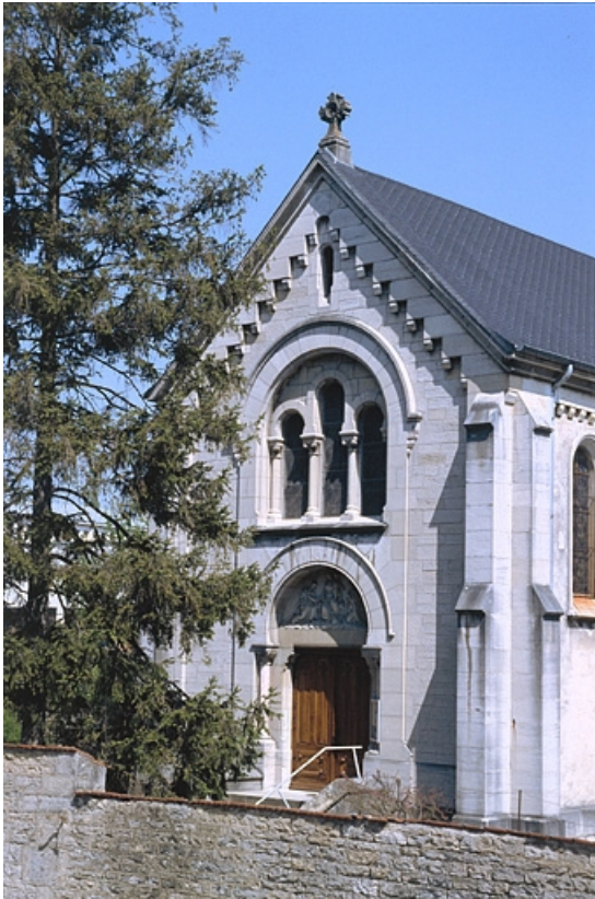
Façade antérieure de la chapelle.
