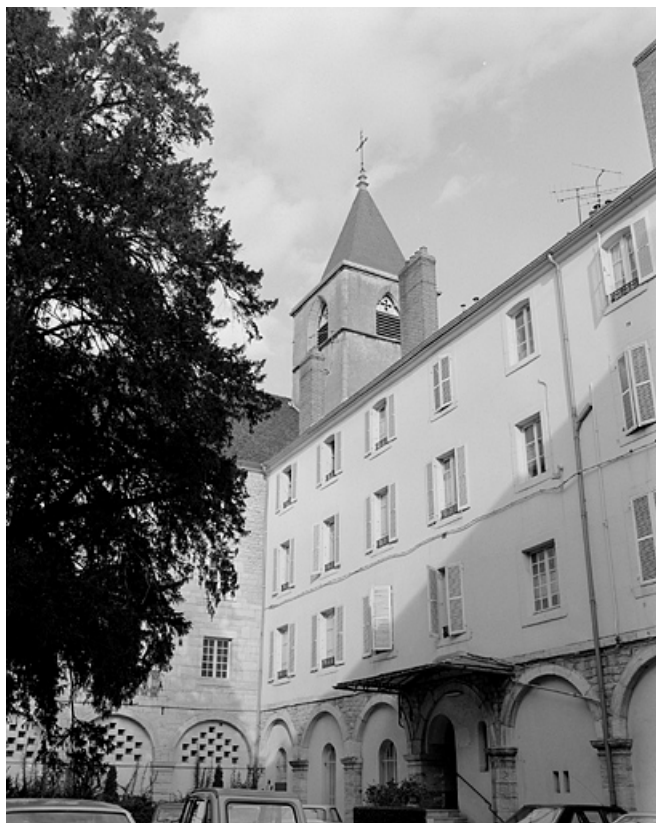
Anciens bâtiments conventuels. Façade sur le cloître côté est. 39, Lons-le-Saunier rue des Cordeliers
