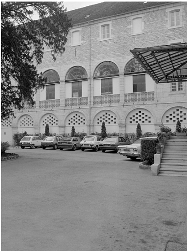
Bâtiments conventuels, cour intérieure, façade nord.
