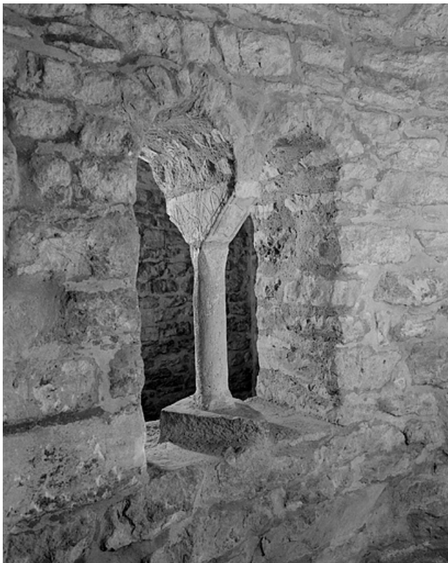
Eglise Saint-Désiré. Crypte, détail d'une baie de l'abside donnant sur le déambulatoire. 39, Lons-le-Saunier, 1 rue de la Préfecture
