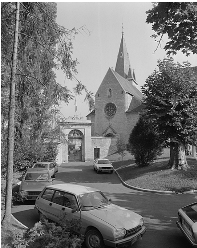
Eglise Saint-Désiré. Façade ouest.
