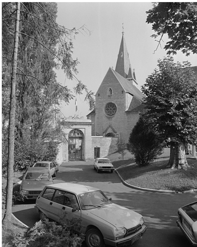
Eglise Saint-Désiré. Façade ouest.
