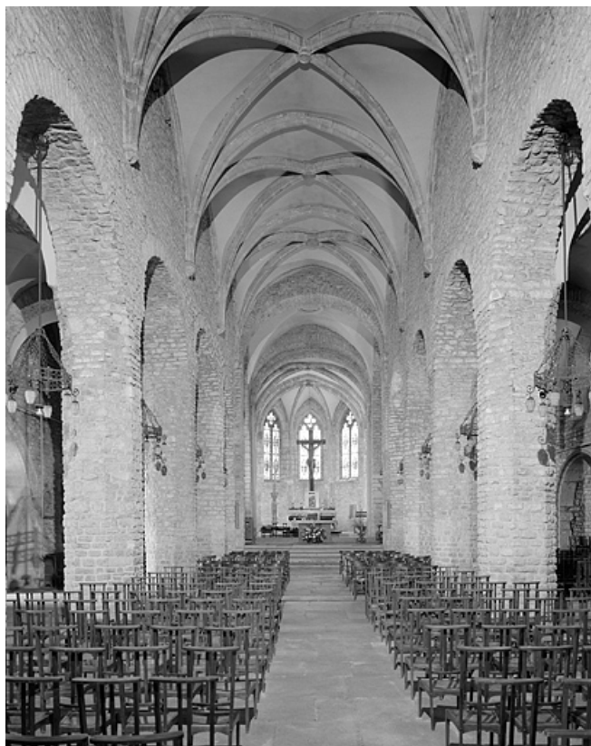
Eglise Saint-Désiré. Vaisseau central vu depuis l'ouest.
