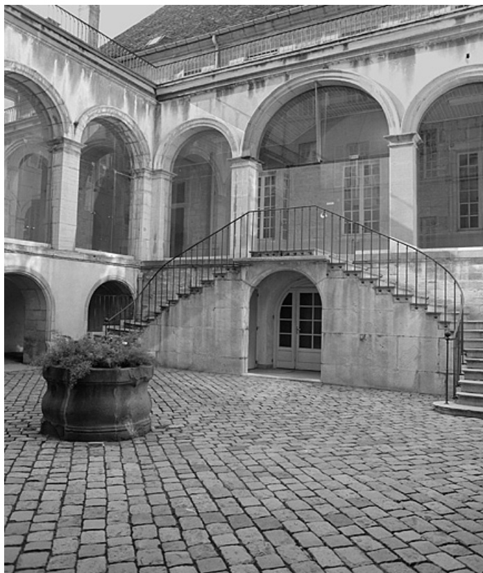
Cour intérieure : vue générale.
