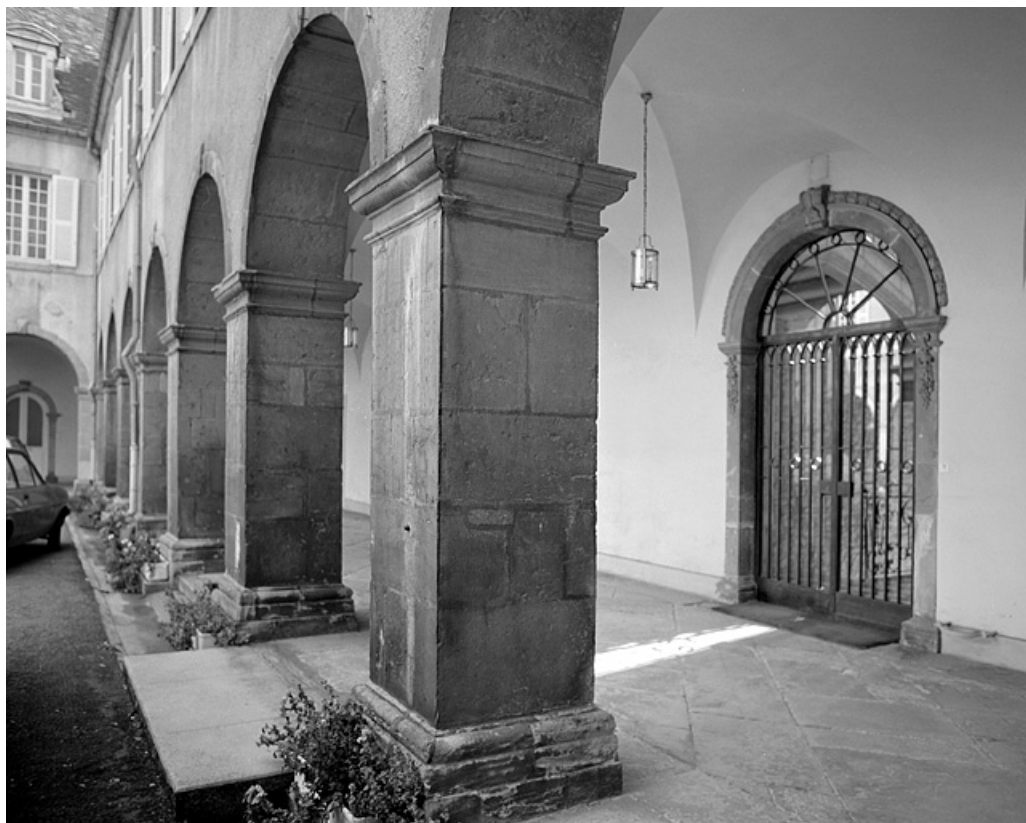
Cloître, galerie sud : porte d'accès à l'escalier.
