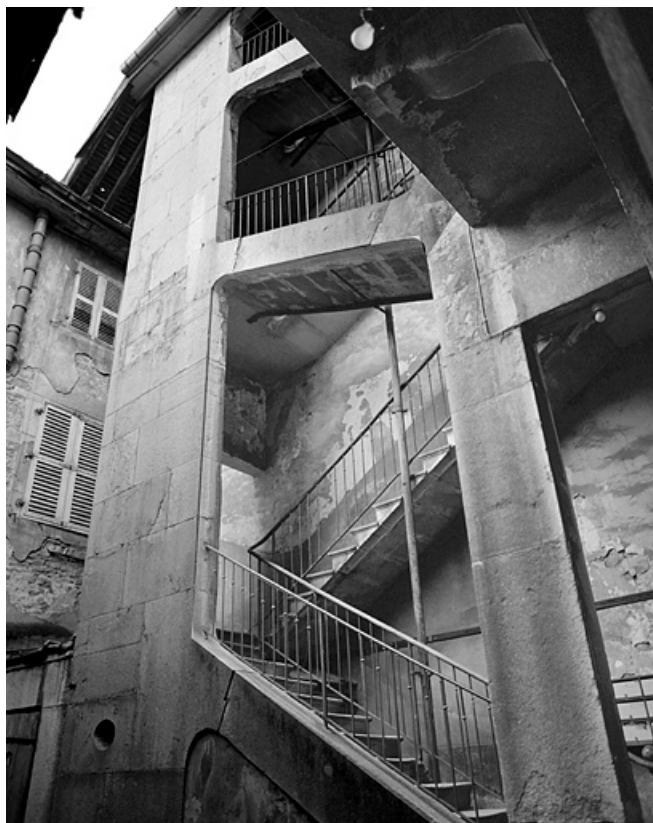
Maison, 16 rue Regard, escalier sur cour. 39, Lons-le-Saunier
