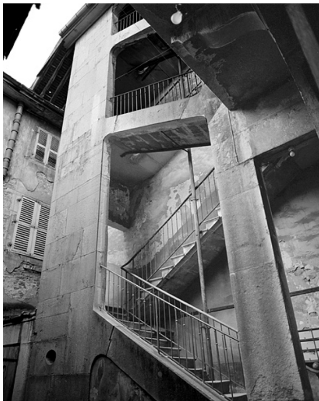
Maison, 16 rue Regard, escalier sur cour. 39, Lons-le-Saunier
