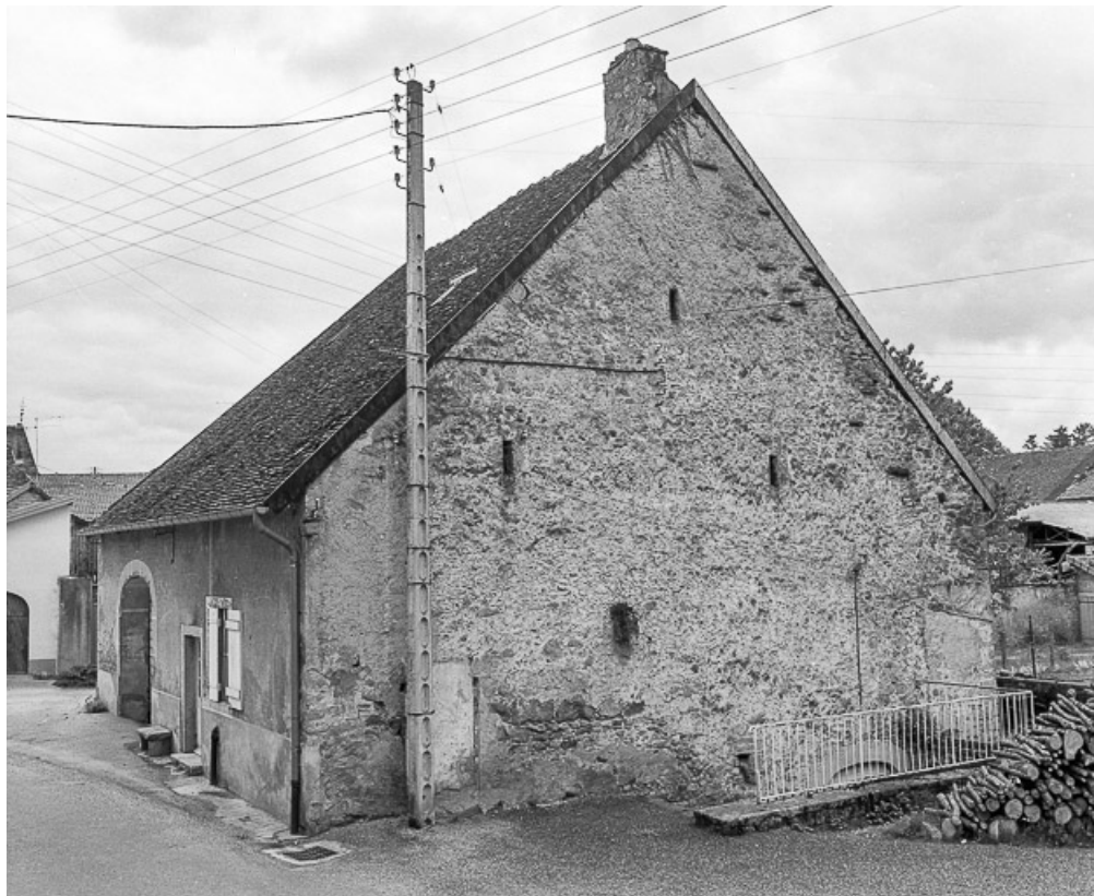
Façades antérieure et latérale droite.
