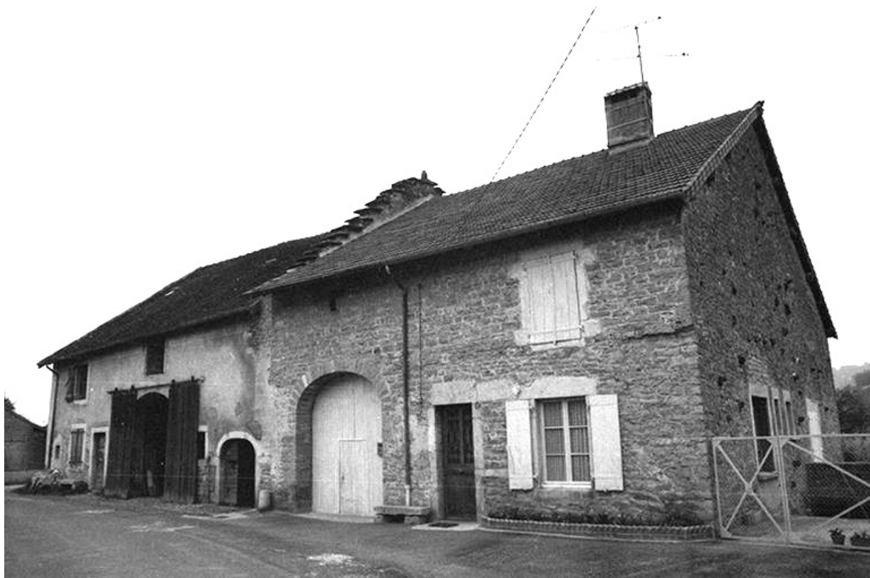
Ferme cadastrée 1961 AH 152-153, située rue des Guichard : façades antérieures. 39, Voiteur
