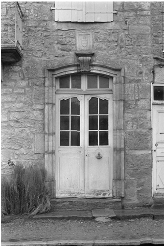
Porte de maison avec blason, 18ème siècle : vue de face 39, Voiteur
