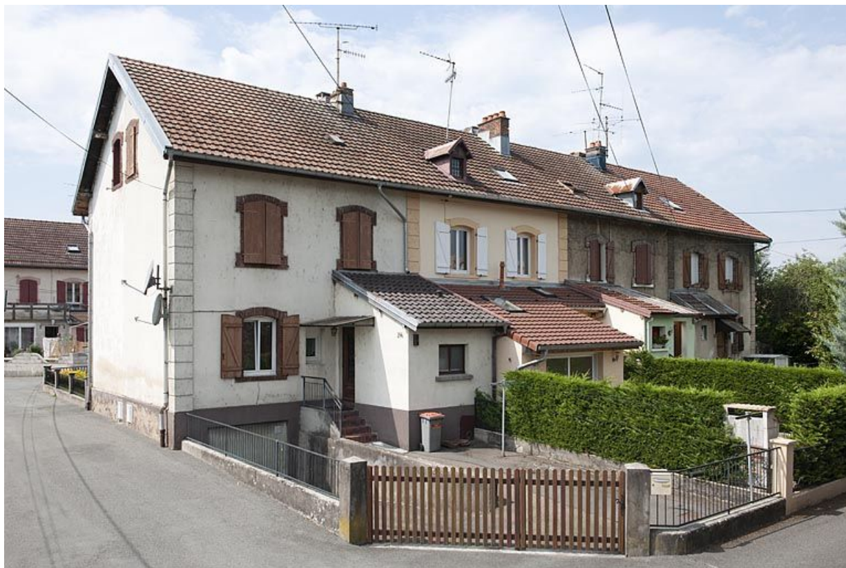
Habitation à 8 logements vue de trois quarts. 25, Audincourt rue Camille Steib
