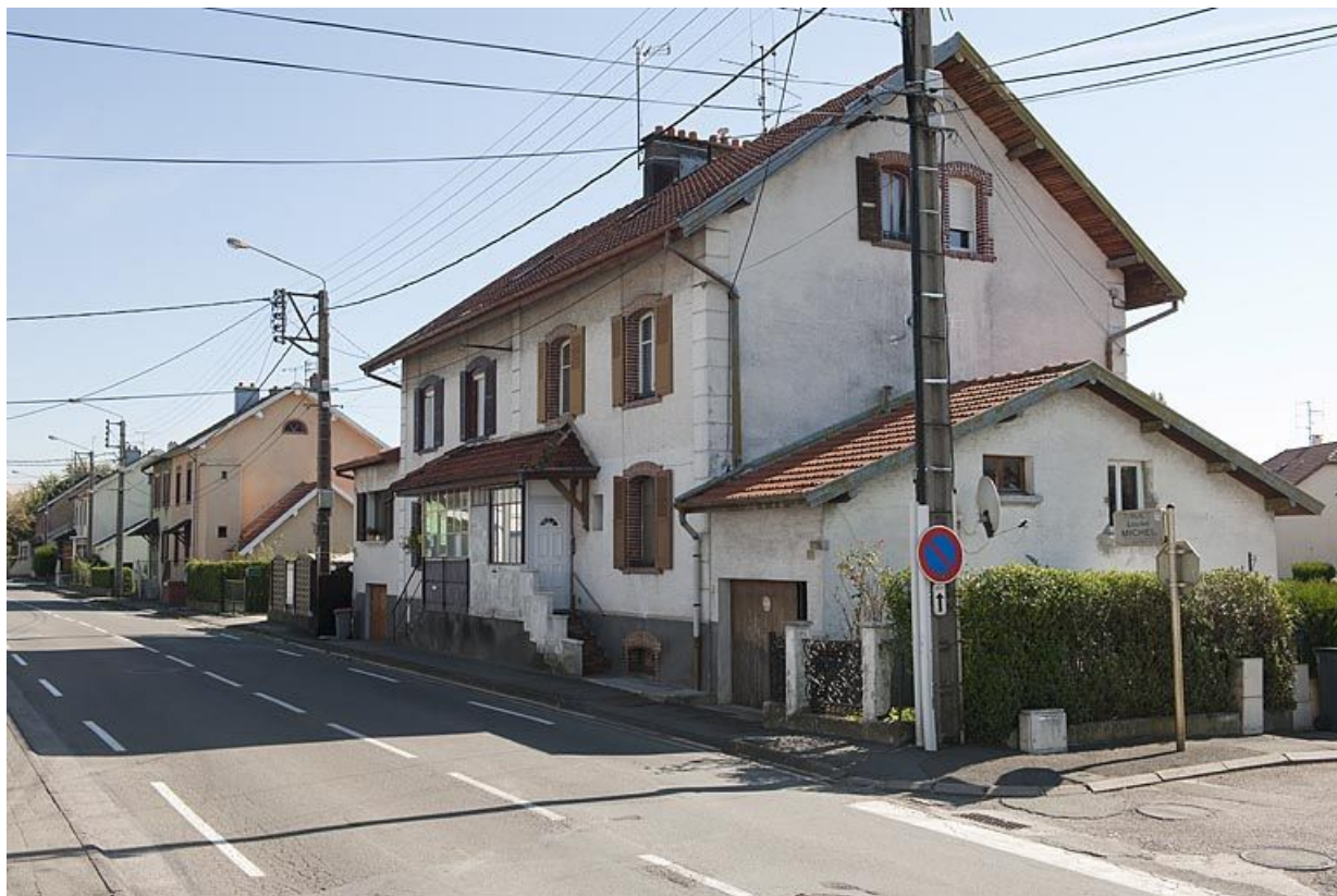
Rue des Mines. Vue d'ensemble des habitations depuis l'ouest.
