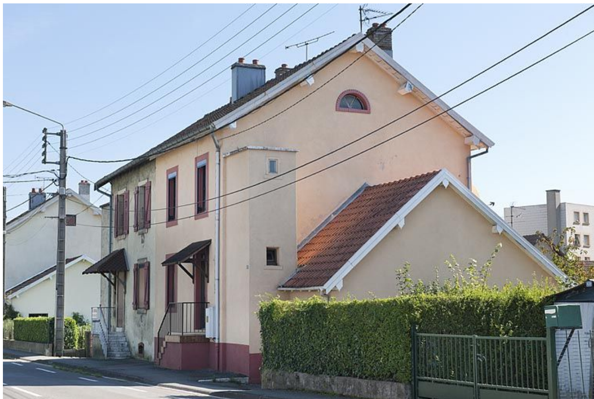
Rue des Mines. Habitation de 4 logements vue de trois quarts. 25, Audincourt rue Camille Steib
