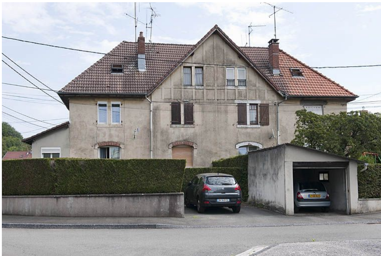
Habitation à 4 logements. Façade postérieure. 25, Audincourt rue des Cités Keller
