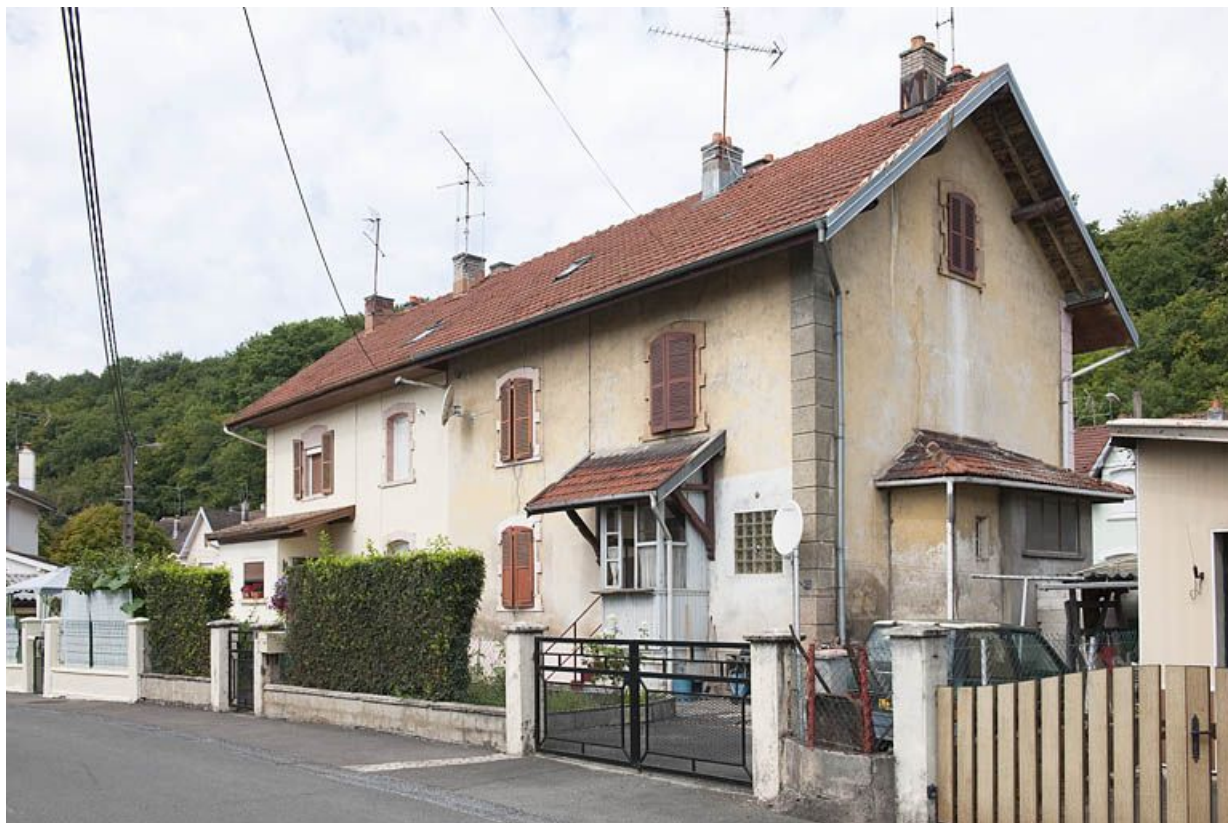
Habitation à 4 logements vue de trois quarts. 25, Audincourt rue des Cités Keller
