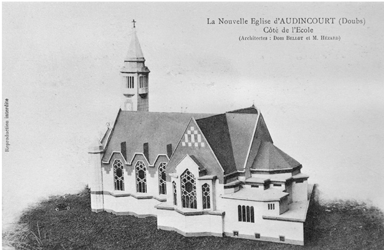
La Nouvelle Eglise d'AUDINCOURT. - Côté de l'Ecole (Architectes : Dom BELLOT et M. HEZARD). 25, Audincourt, 2 rue du Presbytère
