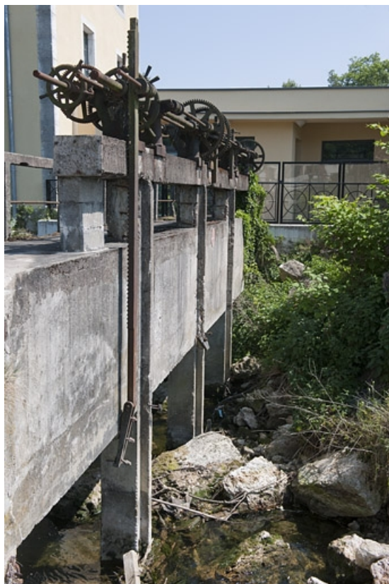
Système de vannage du bief de dérivation.
