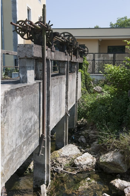
Système de vannage du bief de dérivation.
