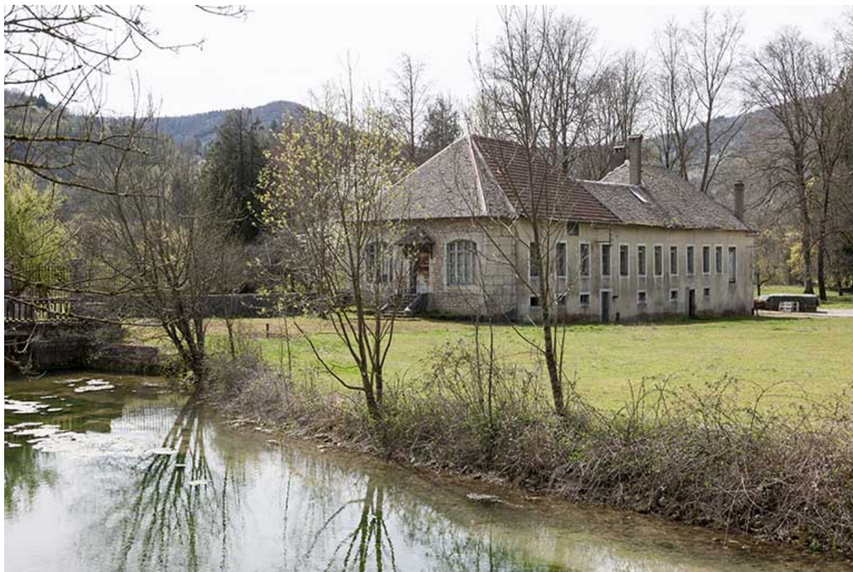
Vue de trois quarts du bâtiment abritant les bureaux, logements, écuries et remises.
