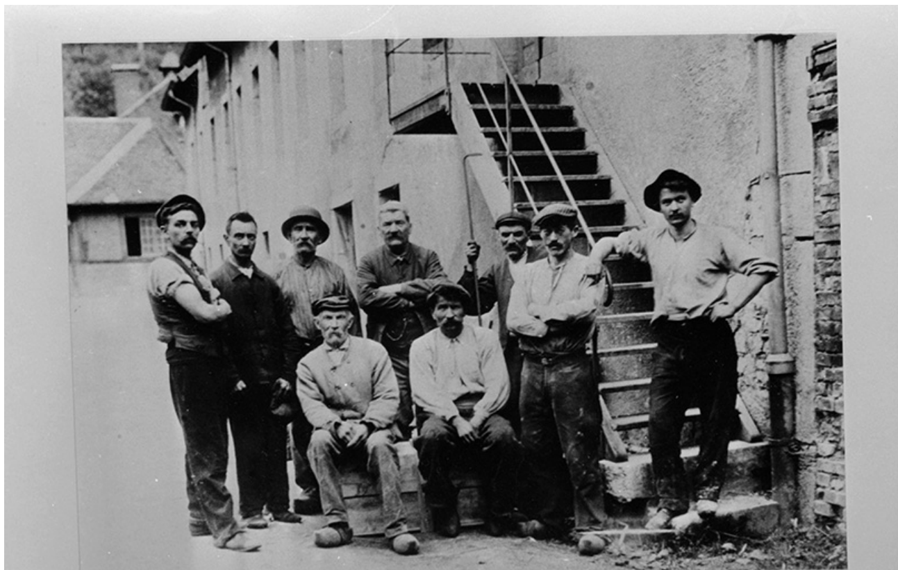
Ouvriers (2), vers 1890-1900. 25, Vuillafans, lieudit : Hauterive
