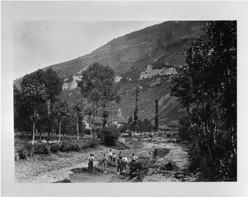
Opération de curage du canal de dérivation en amont d'Hauterive, après 1903. 25, Vuillafans, lieudit : Hauterive
