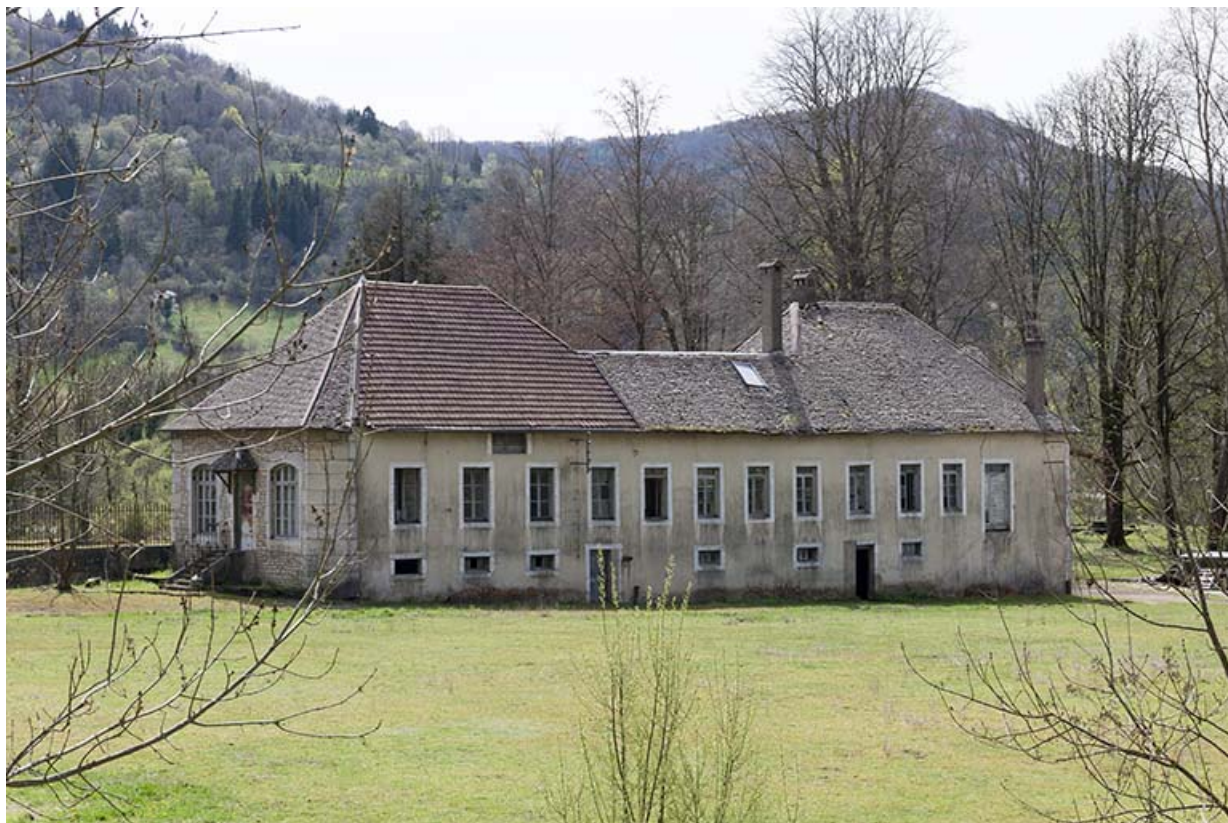
Bâtiment abritant les bureaux, logements, écuries et remises.
