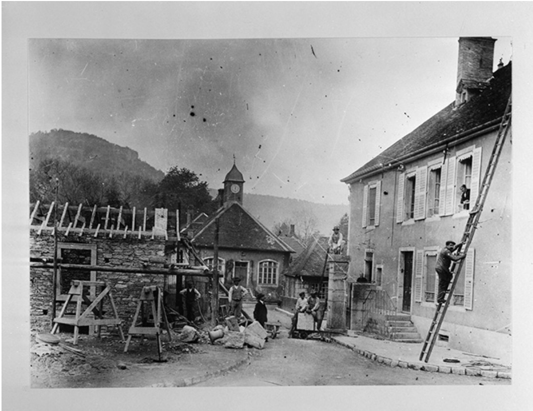
Construction de la conciergerie, vers 1930. 25, Vuillafans, lieudit : Hauterive
