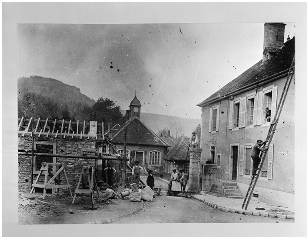
Construction de la conciergerie, vers 1930.
