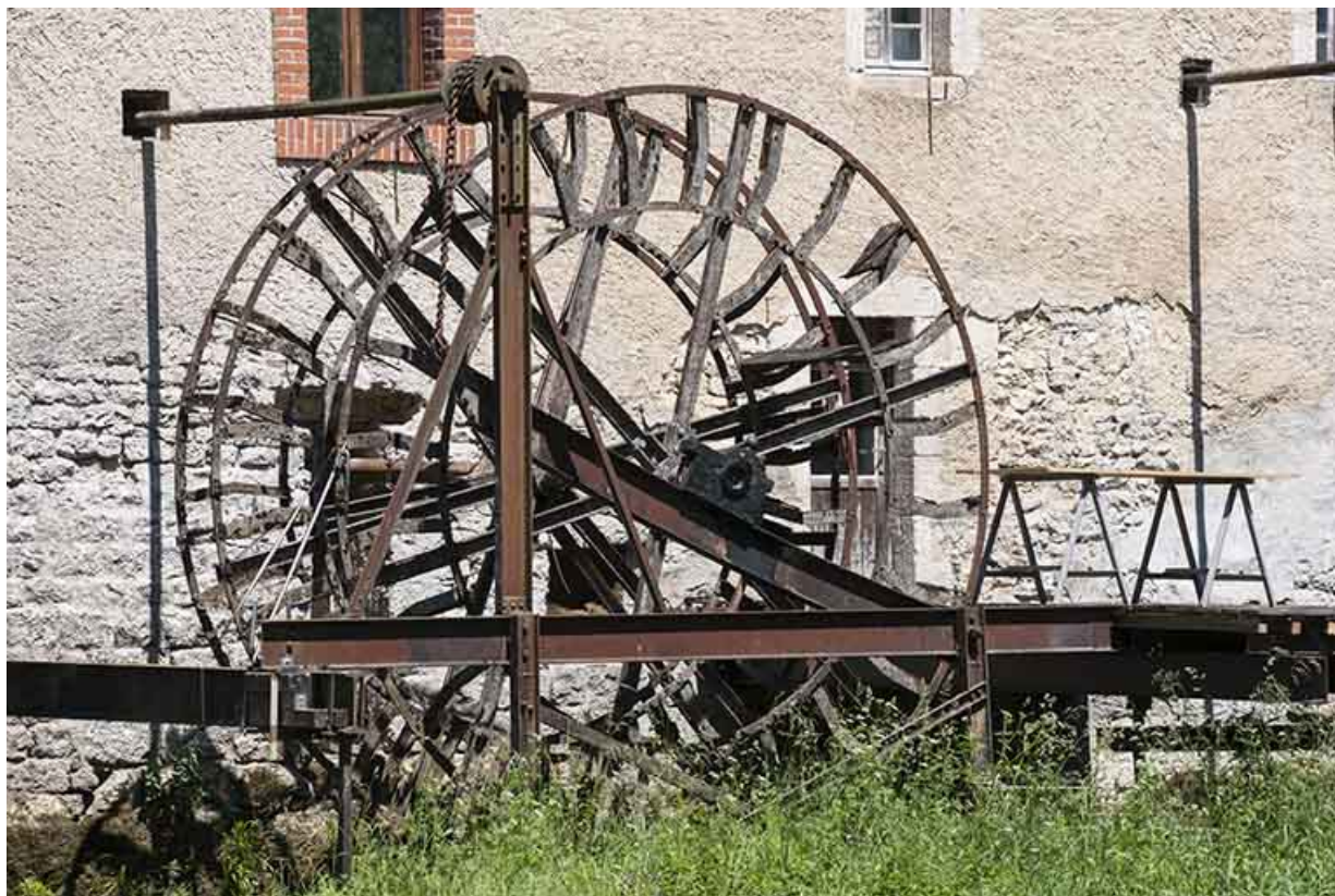
Roue hydraulique aval depuis la rive droite.
