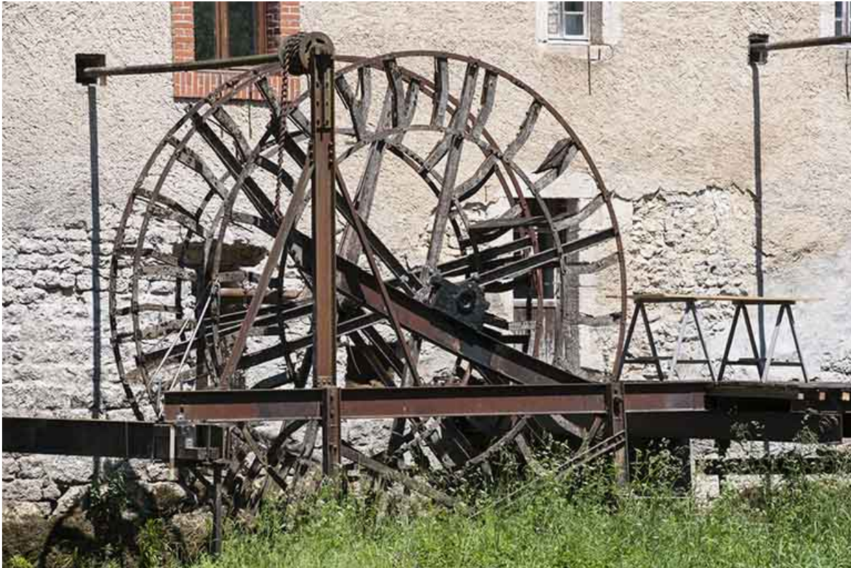
Roue hydraulique aval depuis la rive droite.
