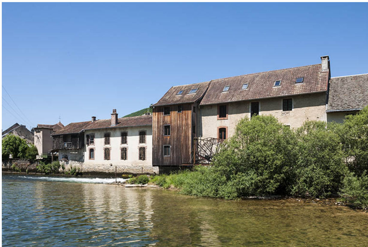
Vue d'ensemble depuis la rive droite.
