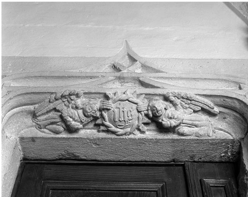
Intérieur : linteau de la porte conduisant à la chapelle. 25, Vuillafans
