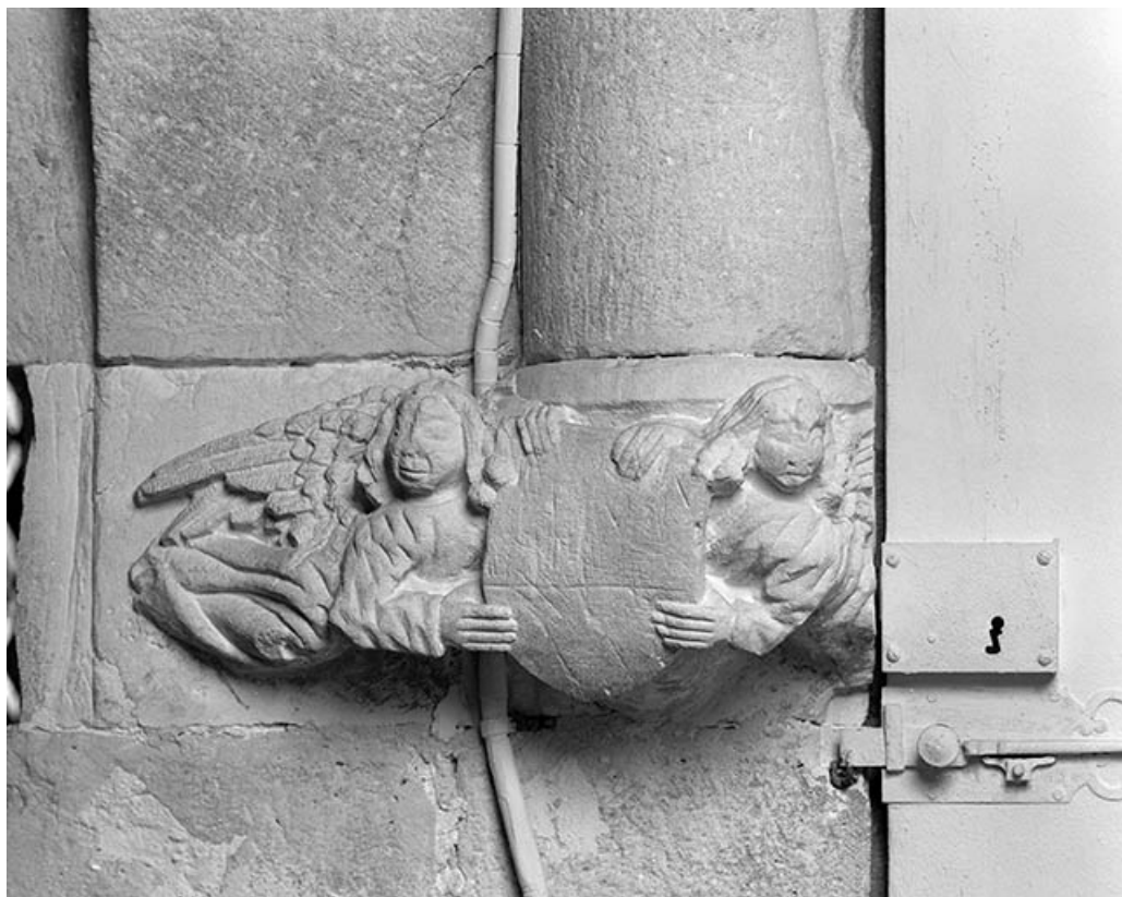
Intérieur : culot à droite de l'entrée de la chapelle. 25, Vuillafans
