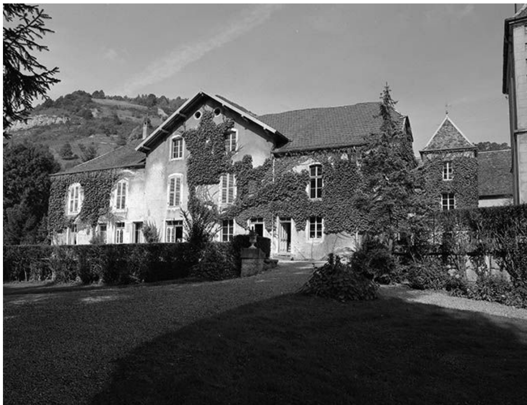
Façade antérieure du logement du gardien.
