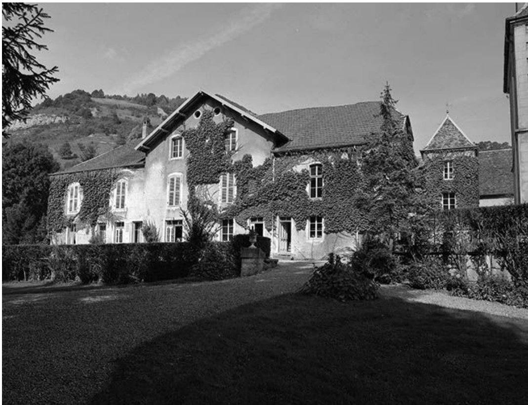
Façade antérieure du logement du gardien.
