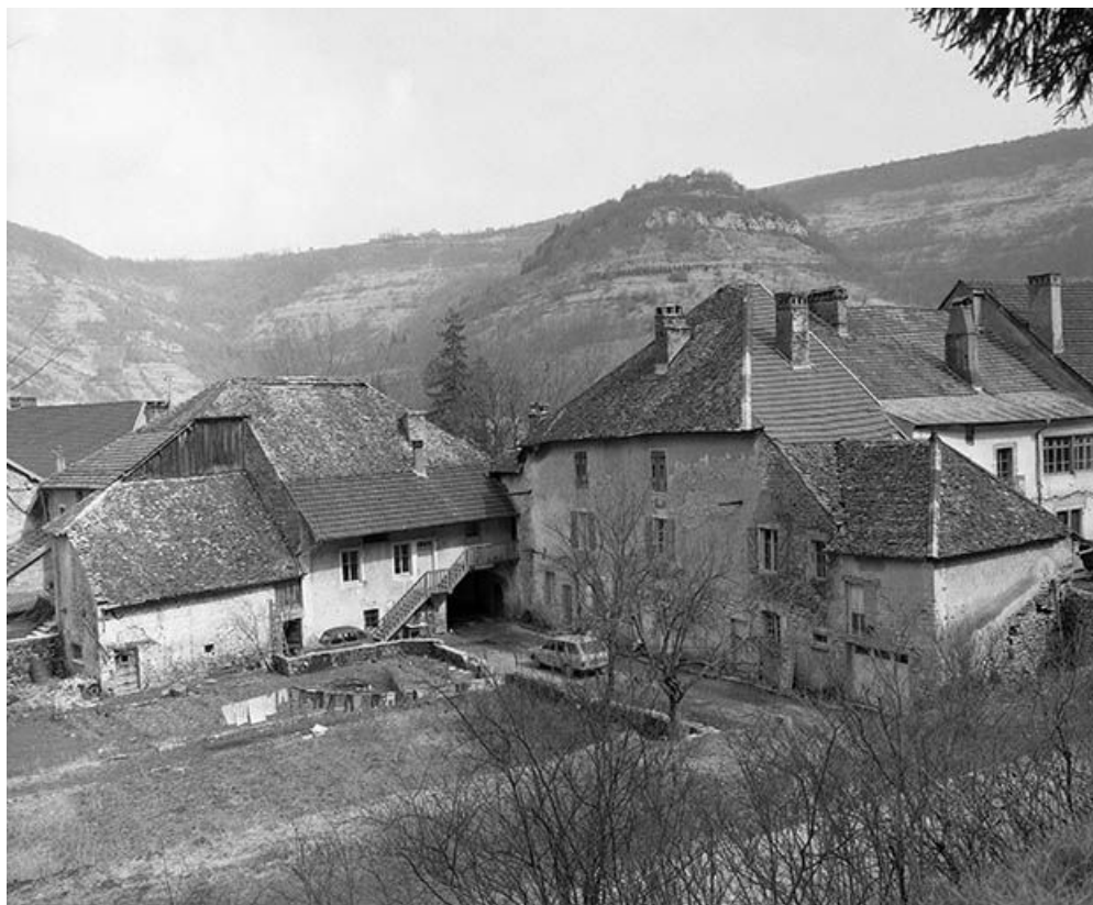
Façade postérieure vue de trois quarts gauche. 25, Vuillafans, 14 rue Gérard
