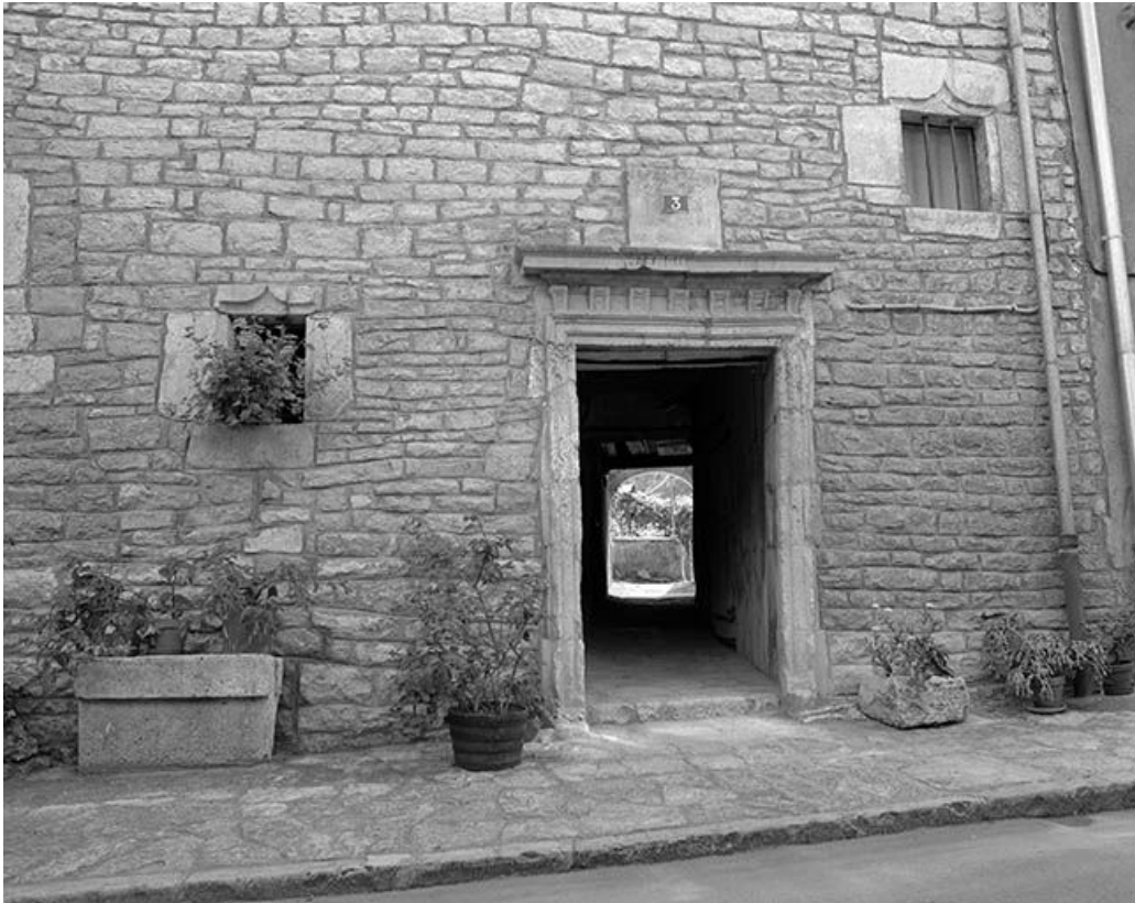
Détail de la façade antérieure : porte conduisant au jardin.
