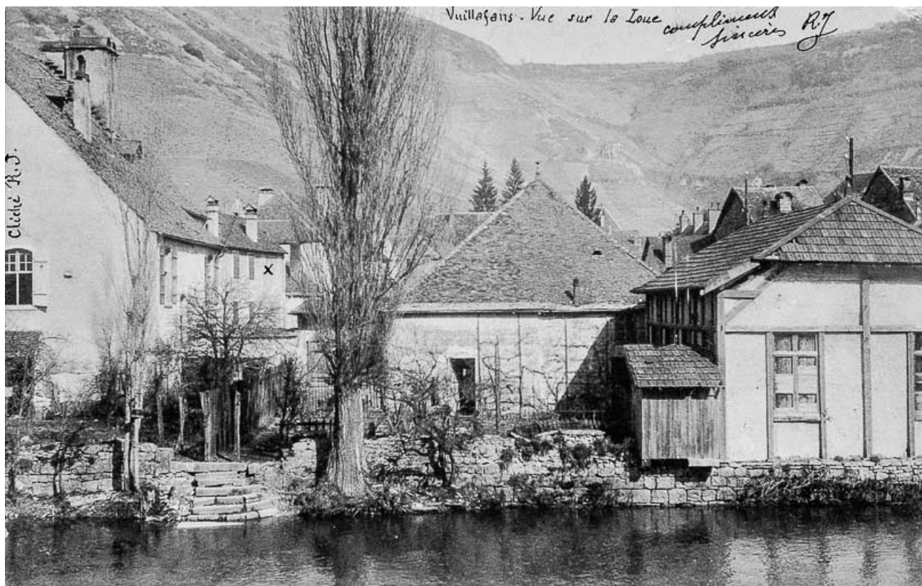
Vue sur la Loue. 25, Vuillafans
