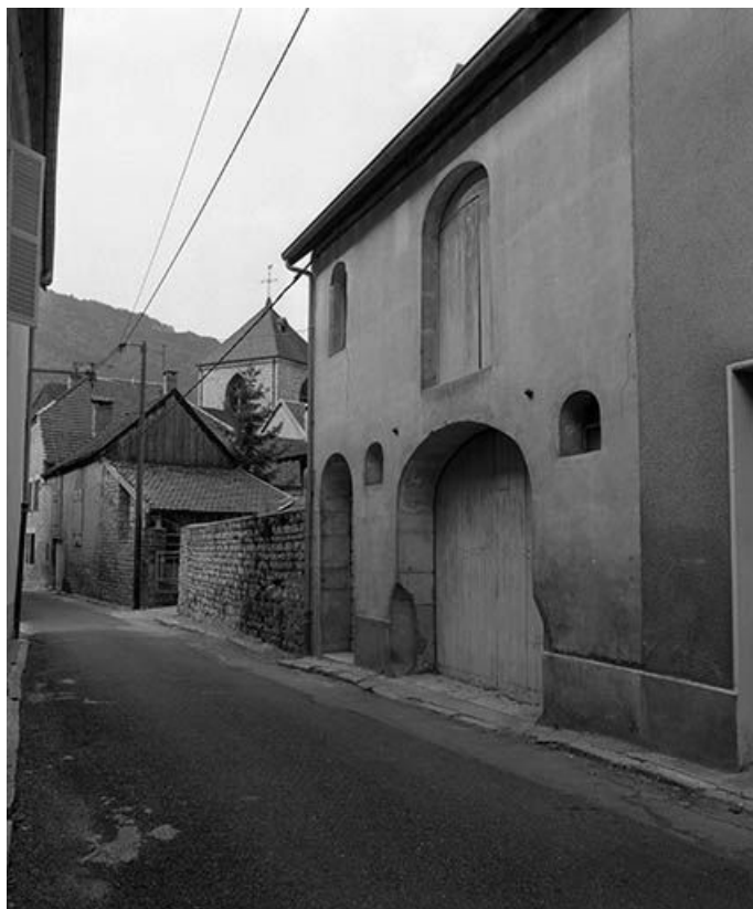
Façade antérieure des parties agricoles d'une maison située rue Jean-Pierre Bangué, cadastrée 1971 AB 65). 25, Vuillafans
