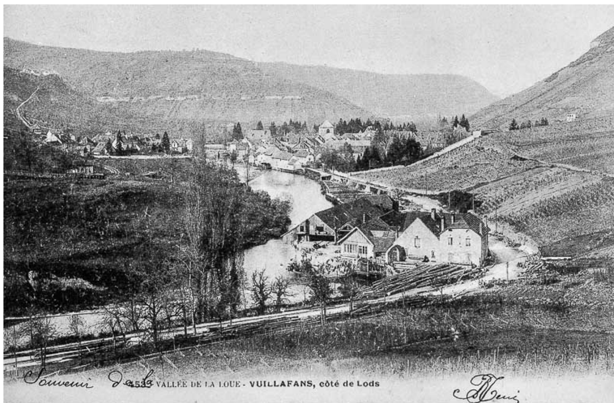
589. VALLEE DE LA LOUE - VUILLAFANS, côté de Lods. 25, Vuillafans
