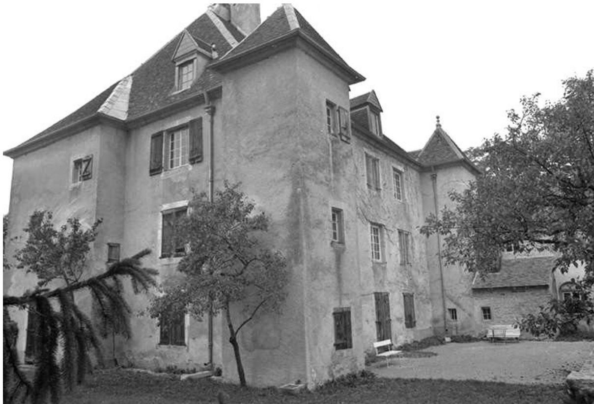
Façade postérieure et face latérale droite. 25, Villers-sous-Montrond rue de Tarcenay
