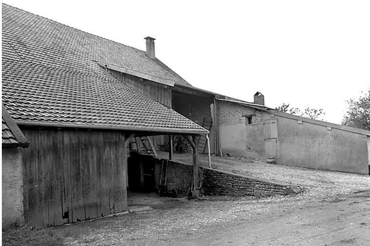
Façade latérale gauche : le pont de grange.
