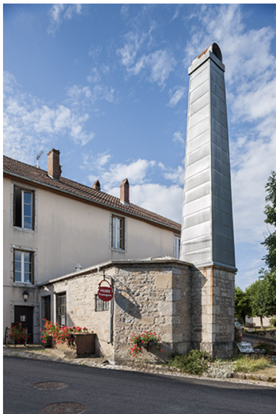
Bâtiment de la fromagerie depuis le nord-est. 25, Trépot, 3 place de la Mairie
