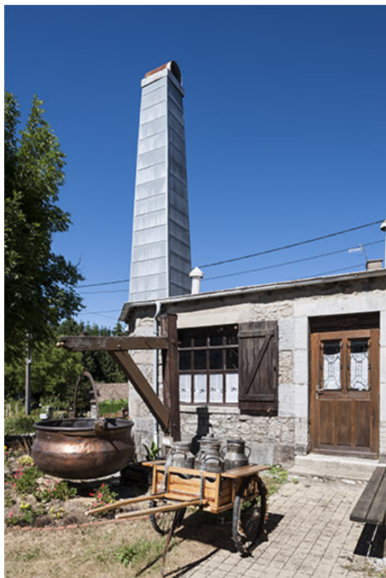
Façade ouest de l'atelier de la fromagerie.
