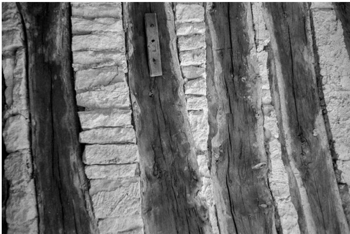
Intérieur des parties agricoles : le plafond.
