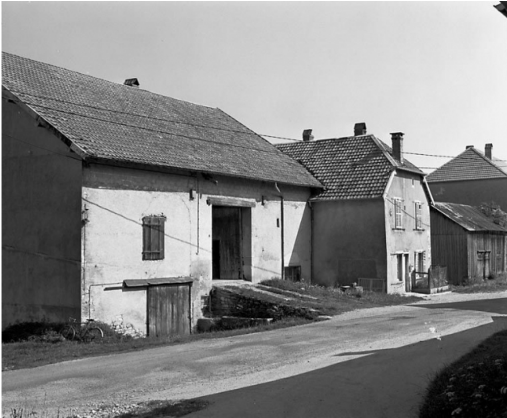
Vue d'ensemble depuis la rue. 25, Trépot
