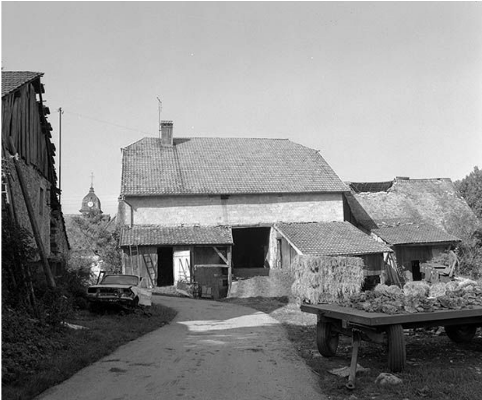
Face latérale : l'entrée de grange.
