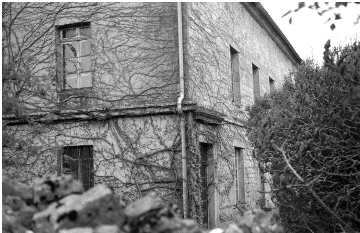
Façade antérieure et face latérale gauche. 25, Trépot, 15 rue du Château
