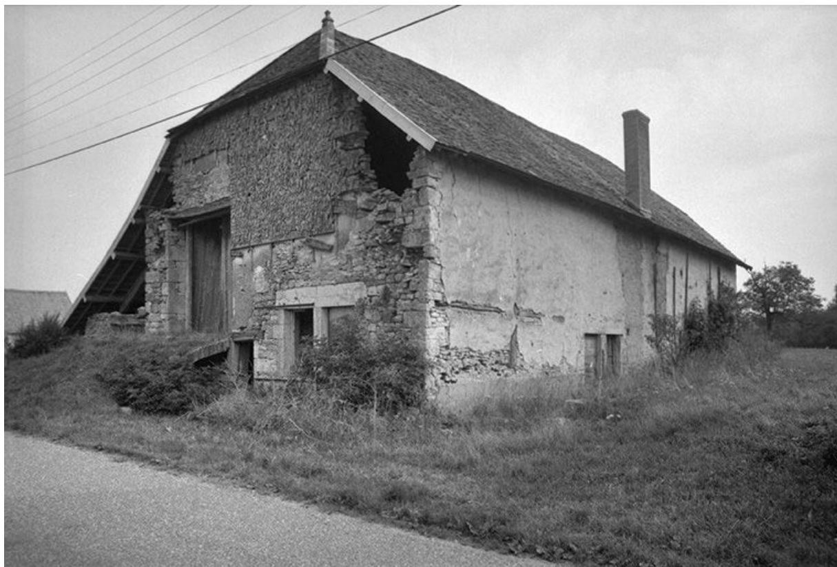
Ferme cadastrée 1972 AB 160 : façade antérieure et façade latérale droite. 25, Trépot
