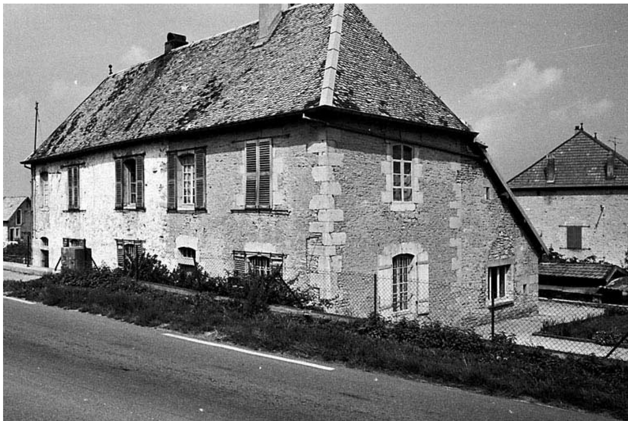
Façade antérieure et face latérale droite. 25, Tarcenay
